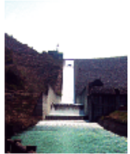
非常用洪水吐からの越流
