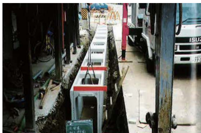
④流雪溝設置状況
