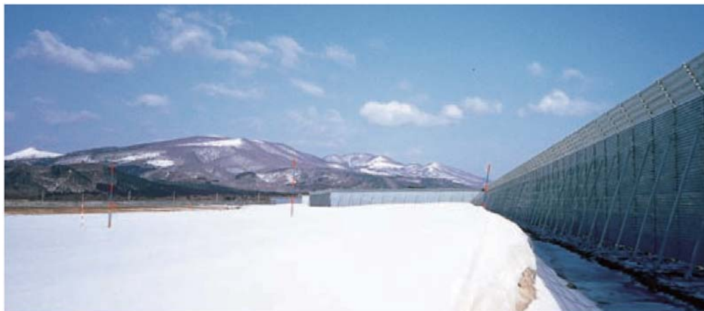
①吹き止め柵の設置状況
