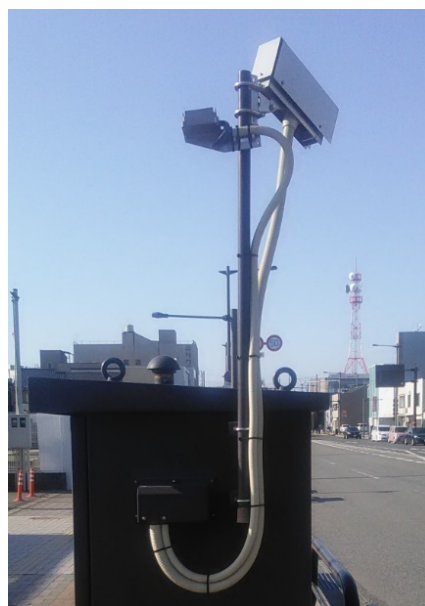
写真－2 マイコン画像処理型の施工実例 ポール上方左側が水分センサ
