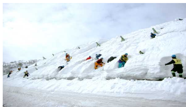
写真2 斜面の維持管理(雪底処理)状況
