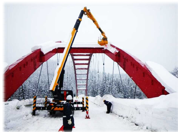
写真1 橋梁部の維持管理(雪底処理)状況
