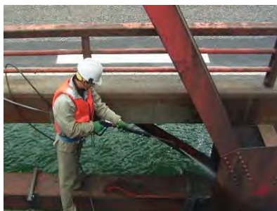
高圧洗浄機による清掃
