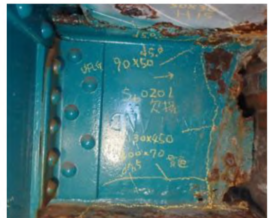
補修前（端桁の腐食）
