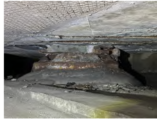
補修前（支承の腐食）
