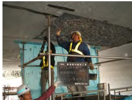
劣化箇所はつり
