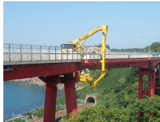
橋梁点検車による定期点検
