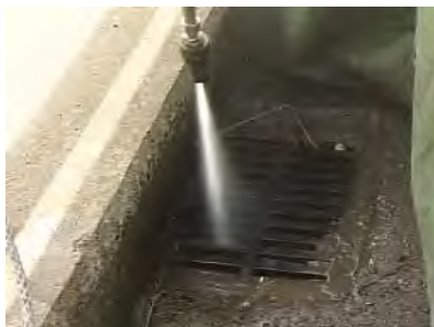
高圧洗浄機による清掃
