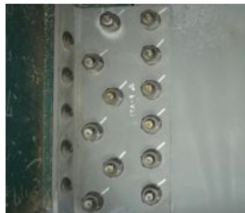
補修後（部材取替）
