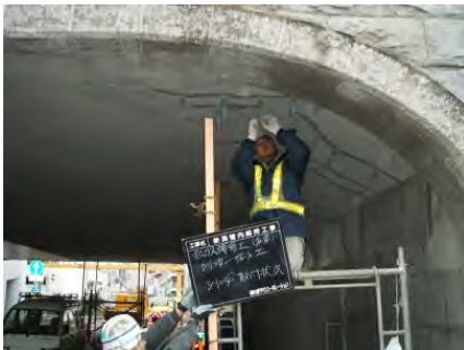
ひびわれ補修
