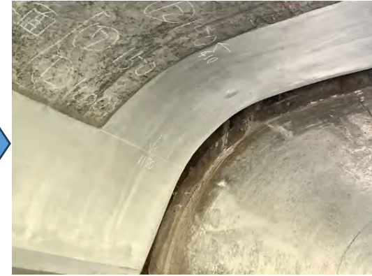
補修後（断面修復）
