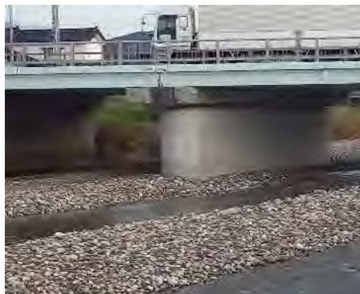
補修前（橋脚基礎部の洗掘）
