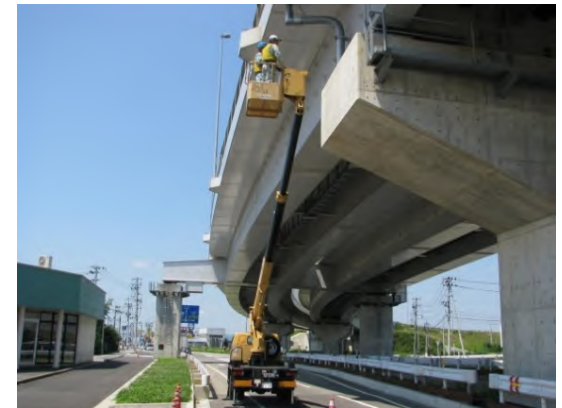
高所作業車による定期点検
