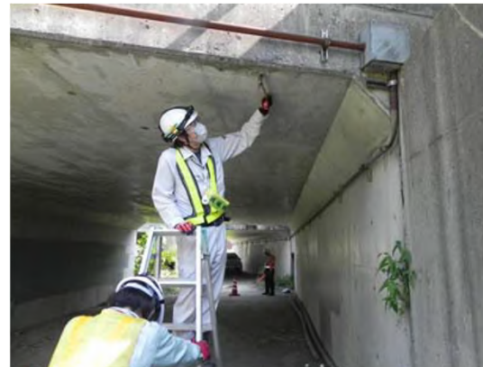
コンクリートの打音調査
