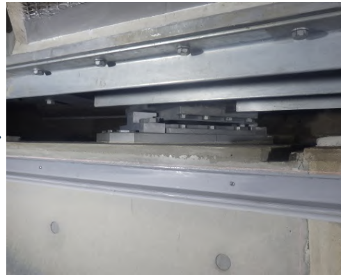
補修後（支承取替）
