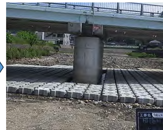
補修後（洗掘対策）
