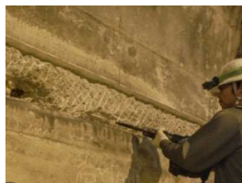
断面修復補修
