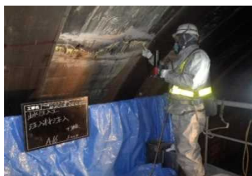
クラック注入補修
