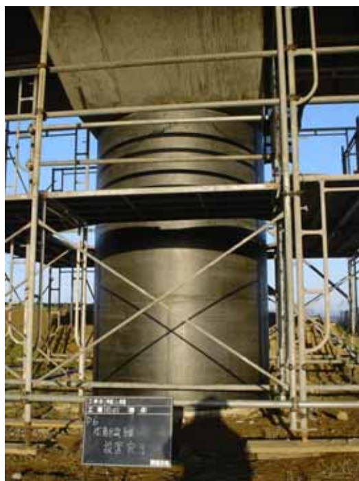
国道8号(新組高架橋)橋脚の復旧(H16.10.29撮影)
