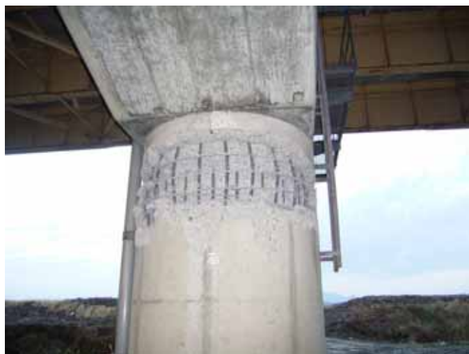
国道8号(新組高架橋)橋脚の被災状況(H16.10.25撮影)
