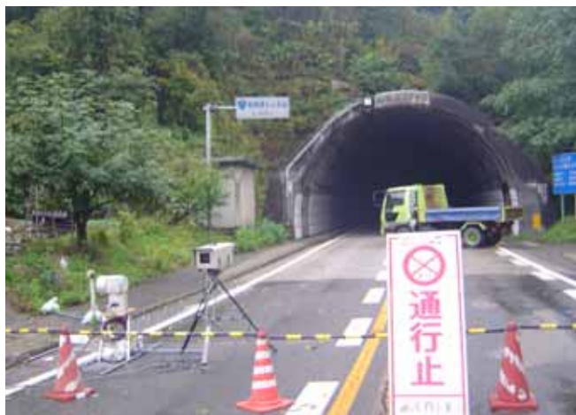
国道17号川口町和南津トンネル 通行止め状況
