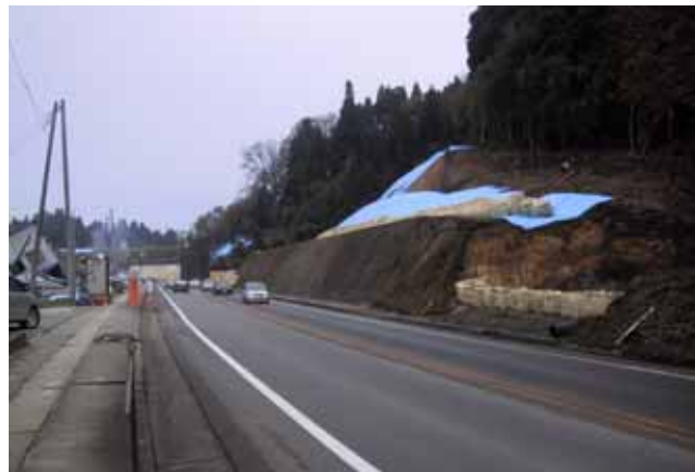
11月18日 国道17号川口町牛ヶ島片側交互通行解除 (H16.11.18撮影)
