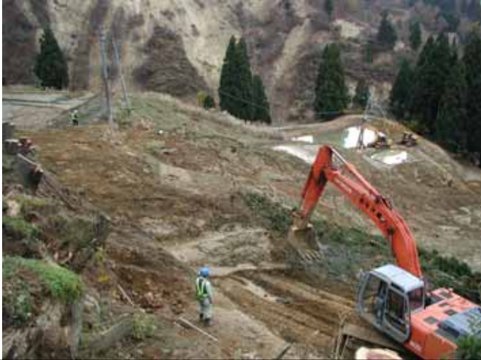
国道291号復旧工事に着手 山古志村竹沢(H16.11.11撮影)
