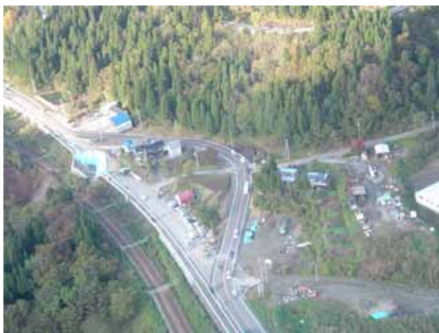
国道17号川口町天納 地権者の協力により迂回路完了 (H16.11.2 撮影)
