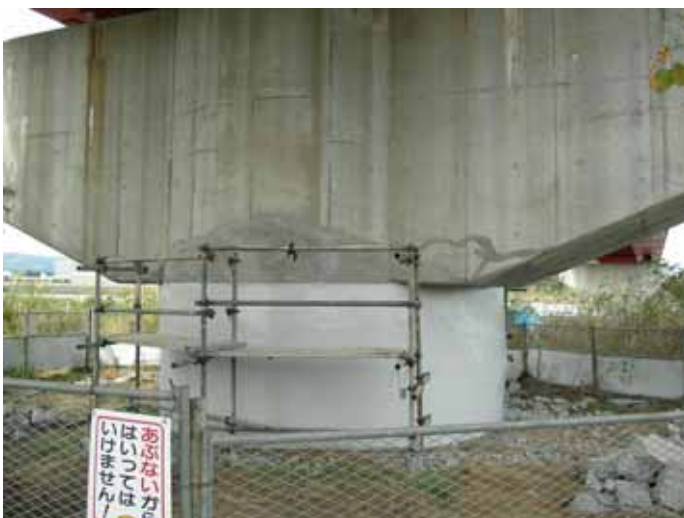
国道17号(小千谷大橋)橋脚の復旧(H16.10.31撮影)
