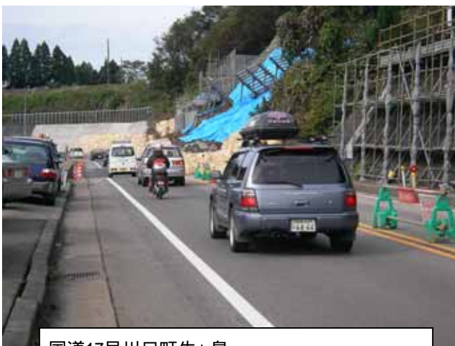
国道17号川口町牛ヶ島 10月29日一般車車両開放 (H16.10.31 撮影)
