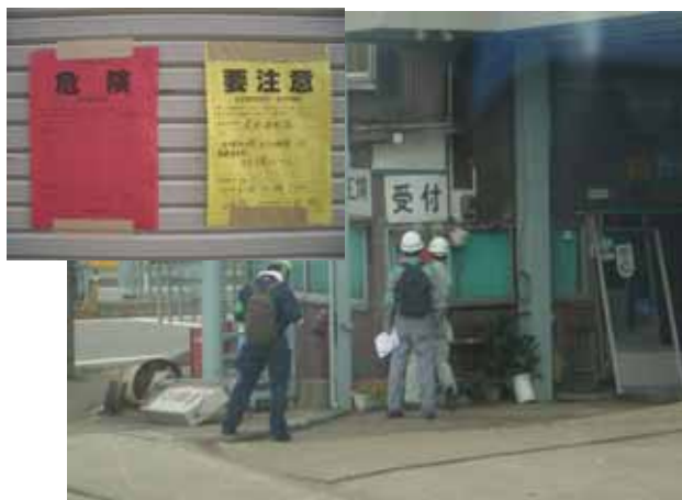
被災建築物の危険度を判定
