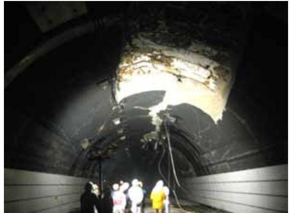
和南津トンネル技術検討委員会による調査
