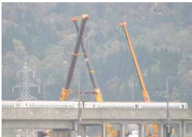
11月10日再開した上越新幹線の撤去作業 (H16.11.11撮影)
