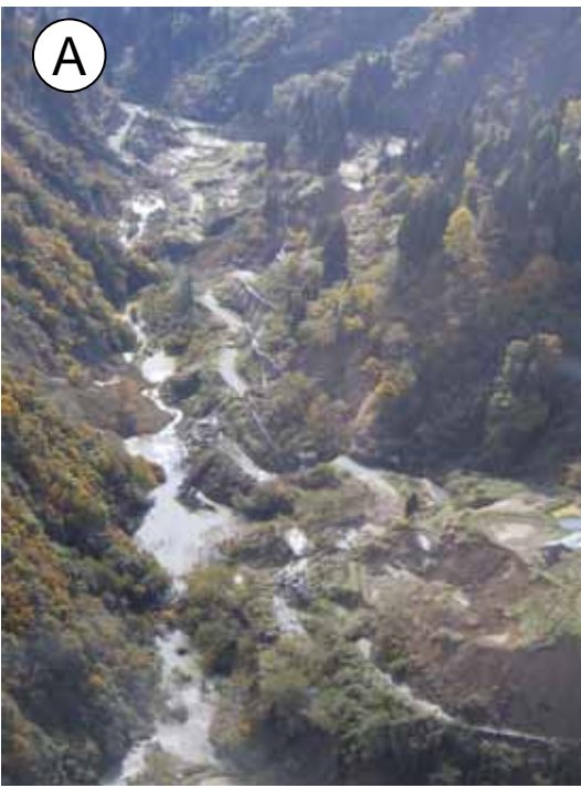
寸断した国道291号と芋川の河道閉塞 山古志村竹沢地内(H16.11.1撮影)
