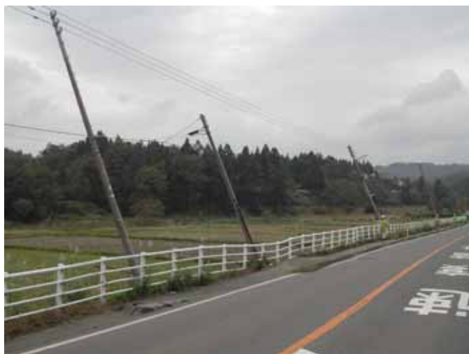
越路町塚山 大きく傾いた電柱 (H16.10.25 撮影)
