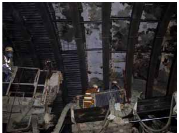
アーチ型H鋼などで、補強しました
