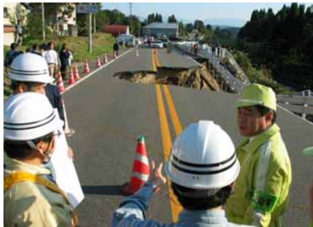
国道17号(川口町天納) 北側国土交通大臣が崩壊箇所を視察 (H16.10.24 撮影)
