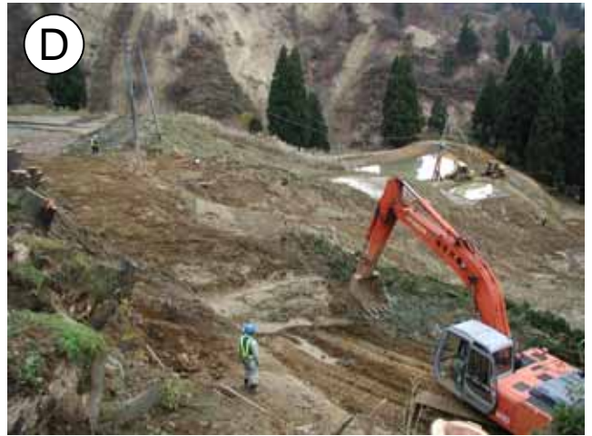
仮道路設置に着手 山古志村竹沢地内(H16.11.11撮影)
