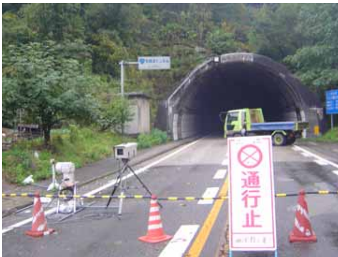
和南津トンネル定点カメラによる監視 (16.10.26撮影)
