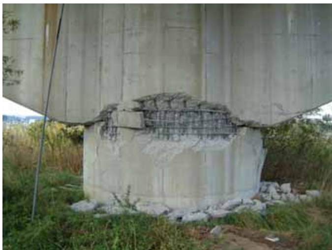
国道17号(小千谷大橋)橋脚の被災状況(H16.10.25撮影)
