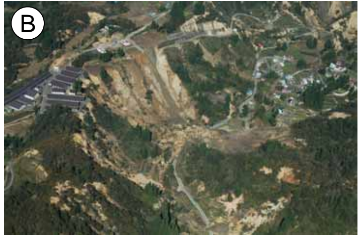
大規模斜面崩落により通行不能 主要地方道柏崎高浜堀之内線 山古志村櫓木地内(H16.10.24撮影)
