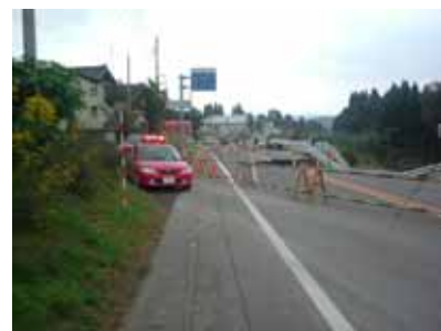
▶ 国道17号川口町天納 応急復旧完了し緊急輸送路確保 (H16.10.25 撮影)
