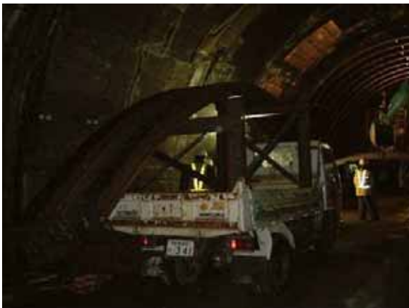
10月26日 応急復旧工事着手
