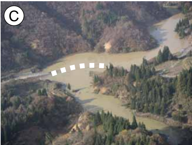
河道閉塞により水没した国道291号 山古志村東竹沢地内(H16.11.5撮影)
