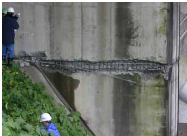
国土技術政策総合研究所及び土木研究所による橋梁下部調査【国道117号 / 山辺橋】(H16.10.26撮影) 写真提供: 独立行政法人土木研究所
