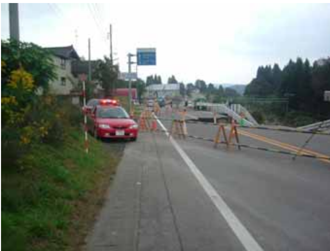
国道17号川口町天納 応急復旧完了し緊急輸送路確保 (H16.10.25 撮影)
