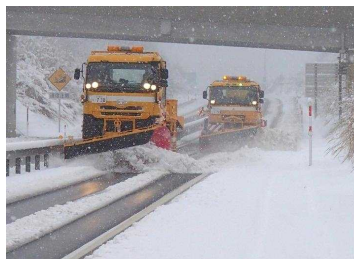
除雪作業の様子 国道470号 石川県穴水町 (H25.12.12撮影)
