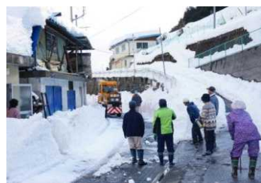
山梨県への除雪支援 町道茂倉線 山梨県南巨摩郡早川町 (H26.2.23撮影)
