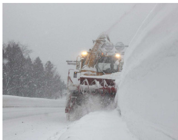
除雪作業の様子 国道17号 新潟県南魚沼郡湯沢町 (H25.1.20撮影)
