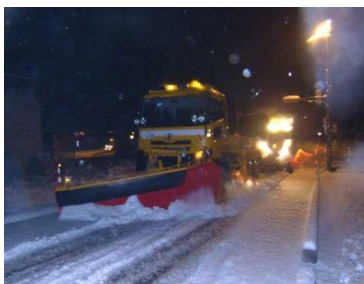
除雪作業の様子 国道8号 石川県小松市 (H25.2.12撮影)
