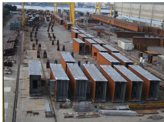
上部工製作中 [H25.1.9 撮影]
