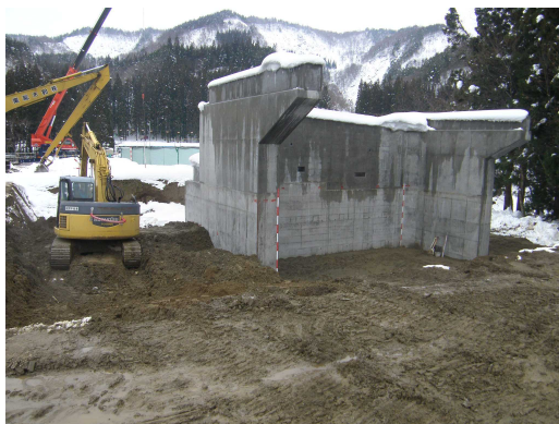
A1 橋台（左岸側）[H25.1.9 撮影]
