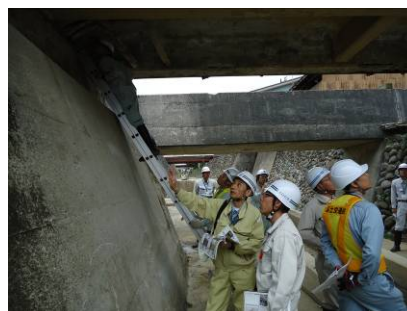
（十日町市が管理している橋での現地検討状況）
