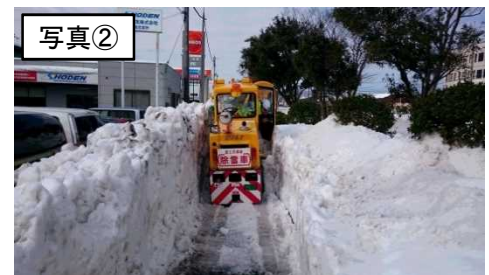
国道9号歩道除雪作業(H29.2.15)
