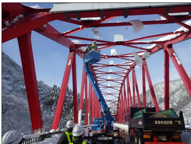
着雪処理【国道113号 新潟県岩船郡関川村】 (H29.1.17撮影)
