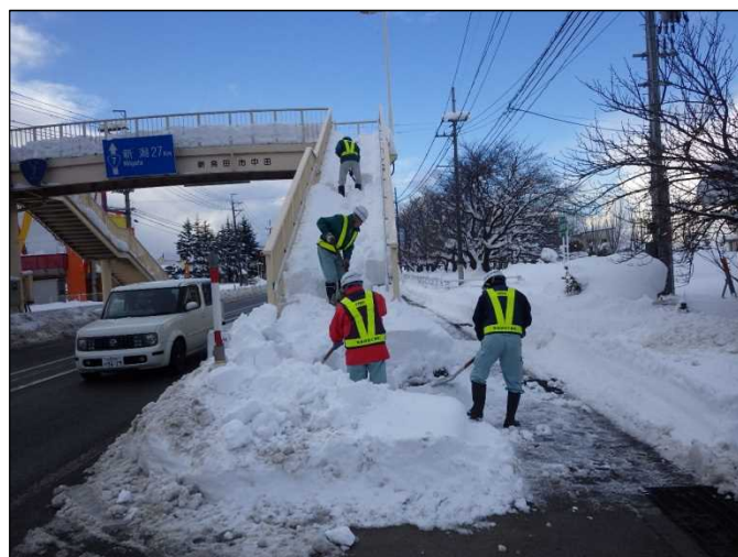
人力除雪【国道7号 新潟県新発田市】 (H29.1.15撮影)
