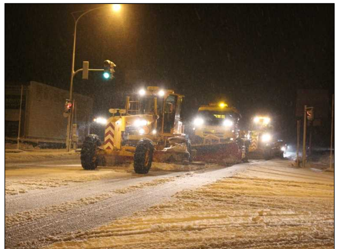
車道除雪（初出動）【国道18号 新潟県妙高市】 (H28.12.6撮影)
