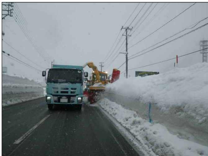
運搬排雪【国道17号 新潟県南魚沼郡湯沢町】 (H29.1.17撮影)
