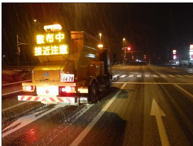
凍結防止剤散布【国道8号 富山県滑川市】 (H28.12.11撮影)
