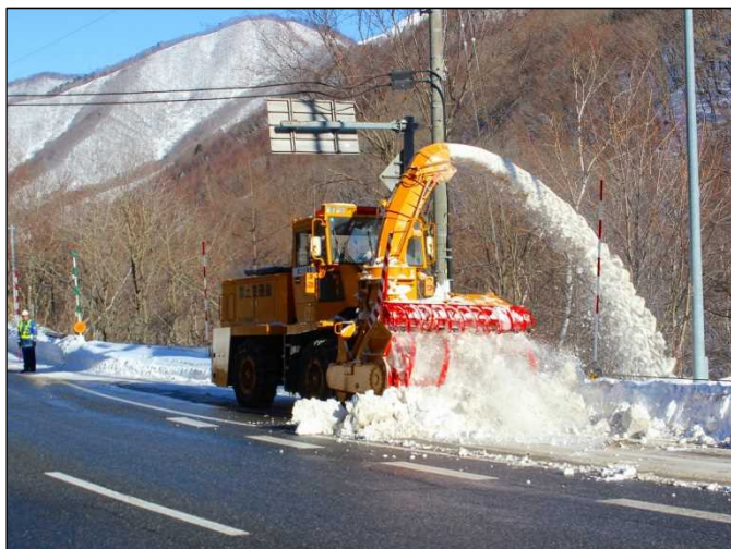
車道除雪【国道17号 新潟県南魚沼郡湯沢町】 (H29.1.6撮影)
