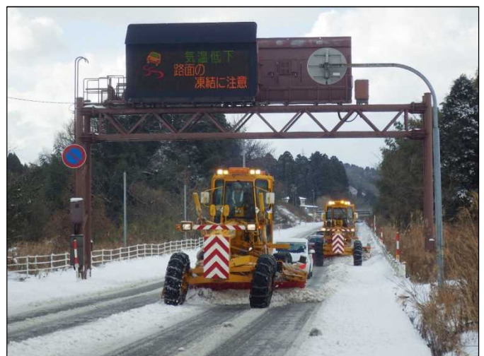
車道除雪【国道8号 石川県河北郡津幡町】 (H29.1.15撮影)
