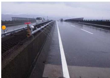
消雪パイプ設置状況 (新組跨線橋上り)
