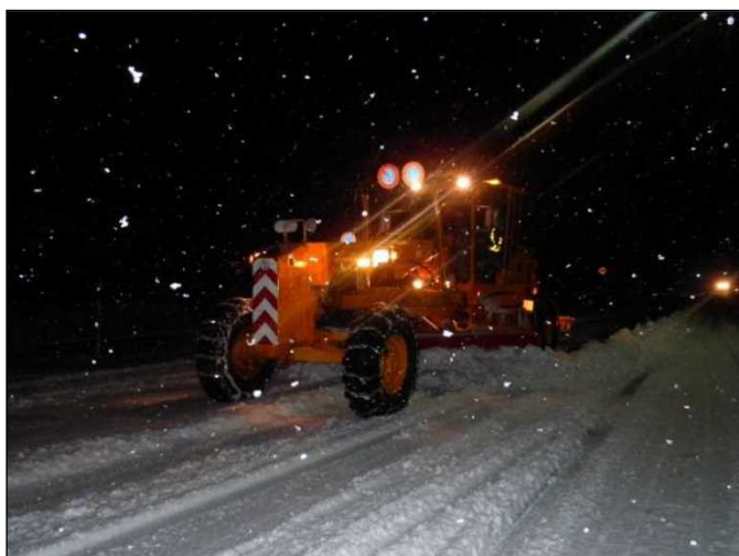
車道除雪（初出動）【国道156号 富山県砺波市】 (H28.12.16撮影)
