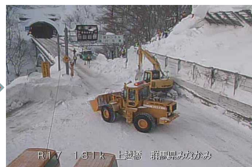
雪庇処理&ポケット確保作業中
