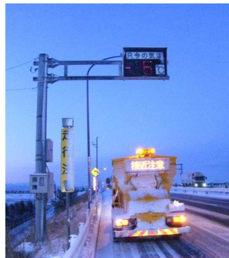
凍結防止剤散布【国道8号 石川県小松市】 (H25.2.16撮影)
