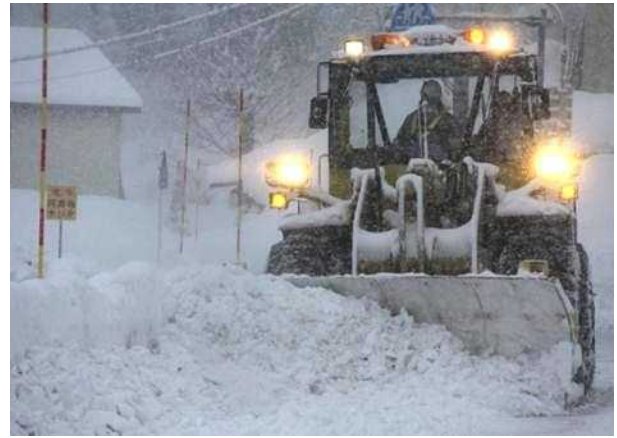
新潟県妙高市長沢地内 国道292号 除雪状況 (H25.1.26撮影)
