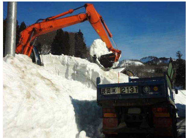
新潟県魚沼市大白川地内 国道252号 ダンプ排雪状況 (H25.1.24撮影)
