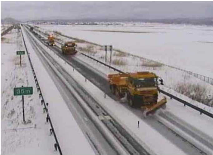
梯団除雪【日東道 新潟県村上市】 (H24.12.25撮影)
