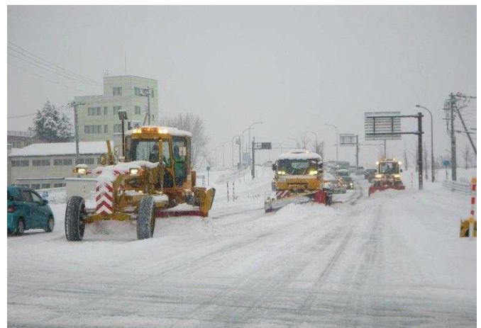
梯団除雪【国道8号 新潟県三条市】 (H25.2.10撮影)
