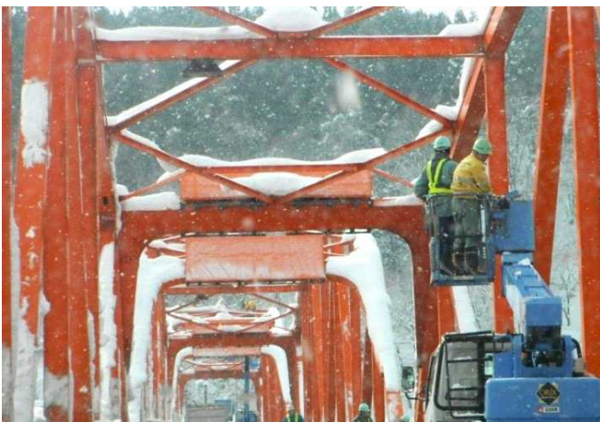
冠雪処理【国道49号 新潟県阿賀町】 (H25.2.13撮影)
