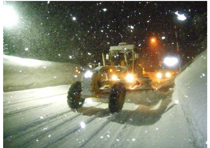
夜間除雪【国道49号 新潟県阿賀町】 (H25.2.22撮影)
