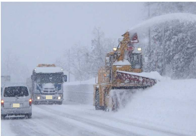
拡幅除雪【国道18号 新潟県妙高市】 (H25.1.4撮影)
