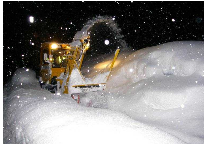
歩道除雪【国道17号 新潟県魚沼市】 (H25.1.4撮影)
