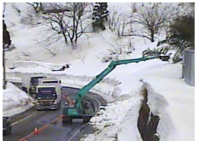
雪庇処理【国道7号 新潟県村上市】 (H25.3.5撮影)
