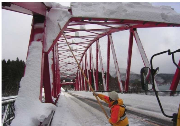
冠雪処理【国道113号 新潟県関川村】 (H24.12.10撮影)
