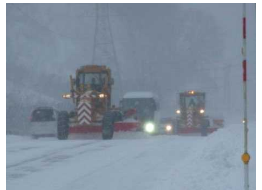
交通量が増加する中での除雪作業 国道17号 新潟県南魚沼郡湯沢町 (H25. 2. 24撮影)
