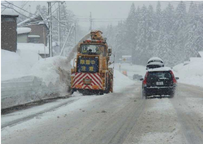
拡幅除雪【国道18号 新潟県妙高市】 (H25.2.21撮影)
