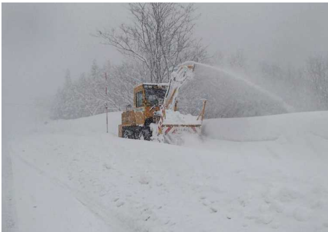
歩道除雪【国道18号 新潟県上越市】 (H25.2.24撮影)
