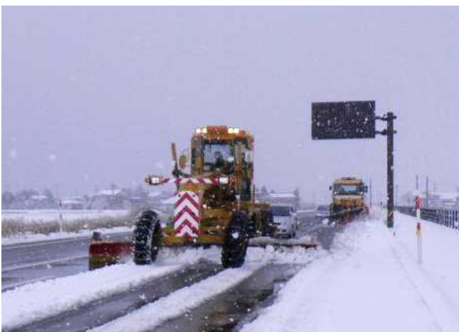
車道除雪【国道8号 富山県入善町】 (H25.3.3撮影)
