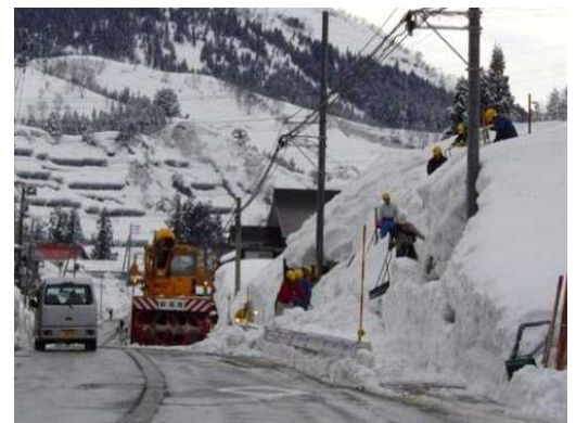
R252 新潟県魚沼市の除雪状況 (H25.2.7撮影)
