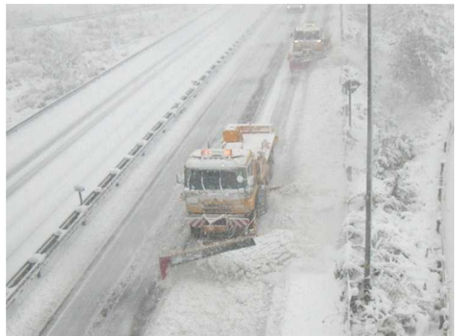
車道除雪【国道7号 新潟県新発田市】 (H24.12.9撮影)
