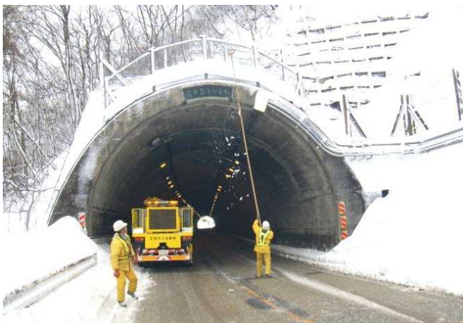
雪庇処理【国道113号 新潟県関川村】 (H25.2.8撮影)
