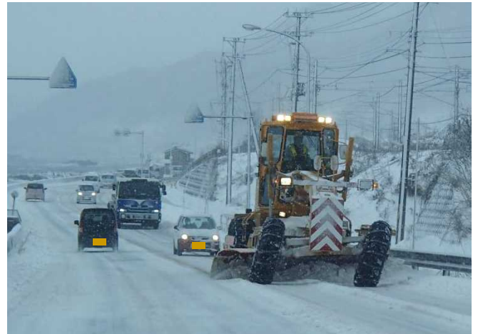
車道除雪【国道8号 新潟県上越市】 (H25.2.25撮影)
