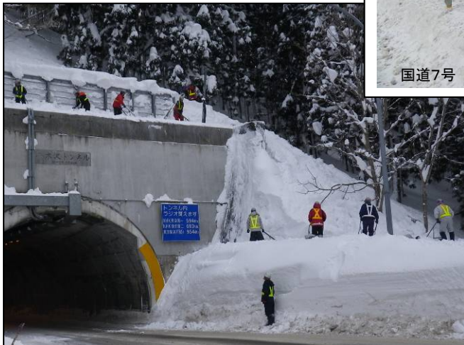
国道17号 新潟県湯沢町 トンネル冠雪処理状況
