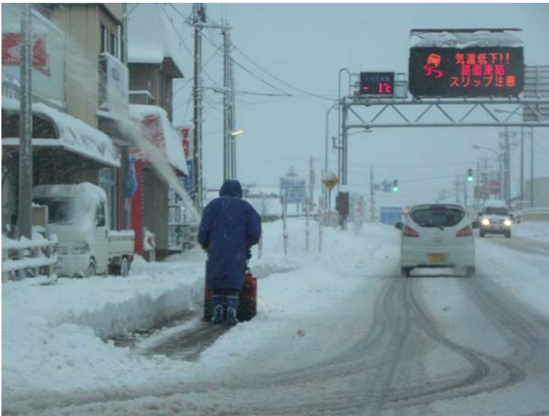
国道7号 村上市石原地内 歩道・側道の除雪作業(H24.1.27)
