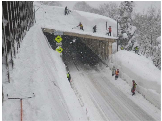
洞門の雪庇処理【国道17号 新潟県湯沢町】 (H24.12.17撮影)
