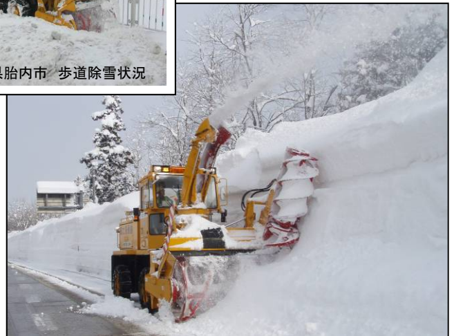
国道18号 新潟県上越市 拡幅除雪状況
