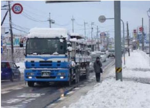
国道8号 黒部市(H24.1.25)
