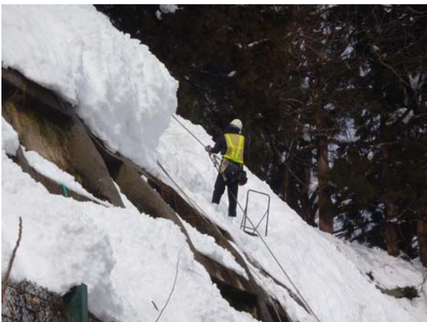
新潟県妙高市除戸地内 雪庇処理作業 (H24.2.5撮影)
