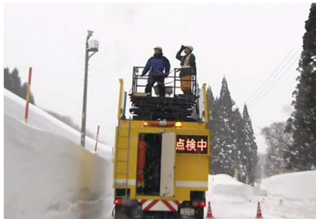
国道17号 新潟県湯沢町 法面点検車による雪崩点検(H24.2.2撮影)
