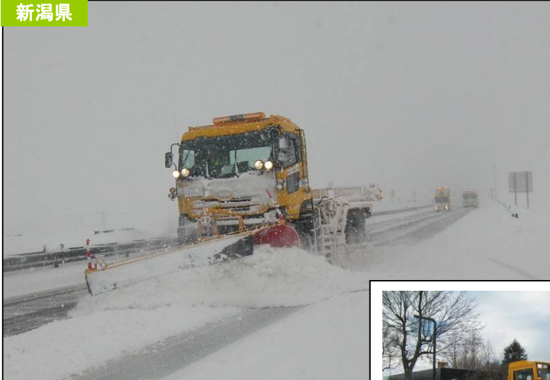
日東道 新潟県村上市 除雪状況
