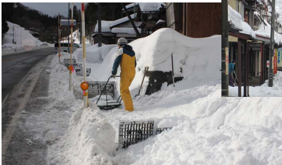
国道7号 村上市葡萄地内 流雪溝への排雪作業 (H24.1.29)
