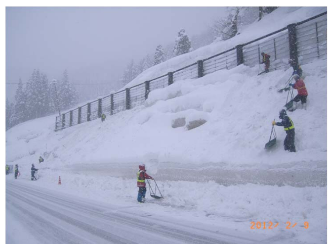
斜面の雪庇処理【国道17号 新潟県湯沢町】 (H24.2.9撮影)
