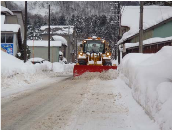
新潟県上越市浦川原区下猪子田地内 除雪状況 (H24.1.12 撮影)
