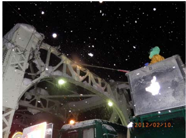
新潟県長岡市 国道351号長生橋 雪庇処理作業 写真提供: 新潟県 (H24.2.10撮影)
