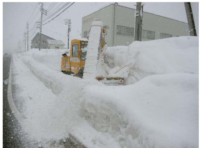
歩道除雪【国道17号 新潟県魚沼市】 (H24.1.26撮影)
