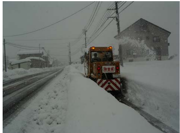
新潟県妙高市姫川原地内 歩道除雪状況 (H23.12.25撮影)
