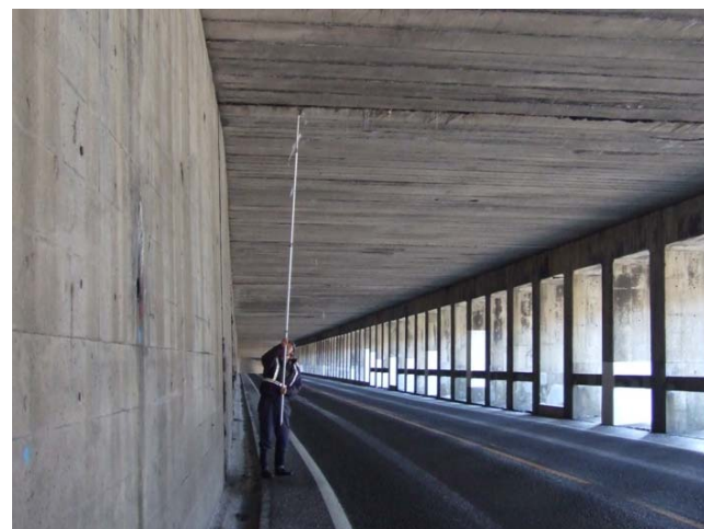
つらら処理【国道17号 新潟県湯沢町】 (H23.12.14撮影)
