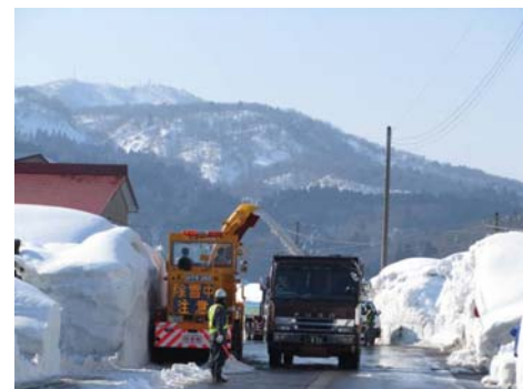
妙高市道姫川原団地西線の排雪作業 富山河川国道の除雪車
