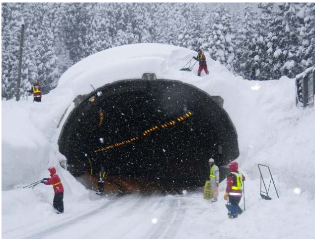
トンネルの雪庇処理【国道49号 新潟県阿賀町】 (H24.2.1撮影)
