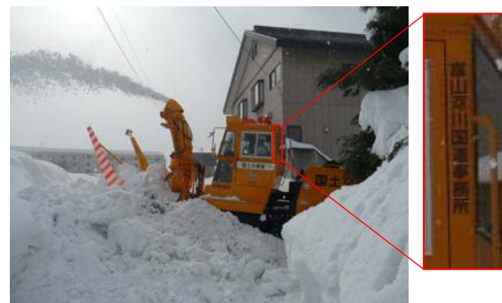
妙高市内を除雪する富山河川国道の除雪車
