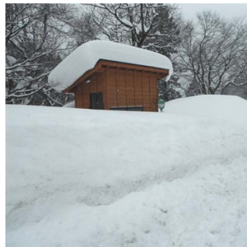
国道49号 新潟県阿賀町 倉ノ平地先(H24.2.2)
