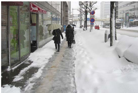
ロードヒーティングのある歩道 国道7号 新潟市中央区万代地先 (H24.2.17)
