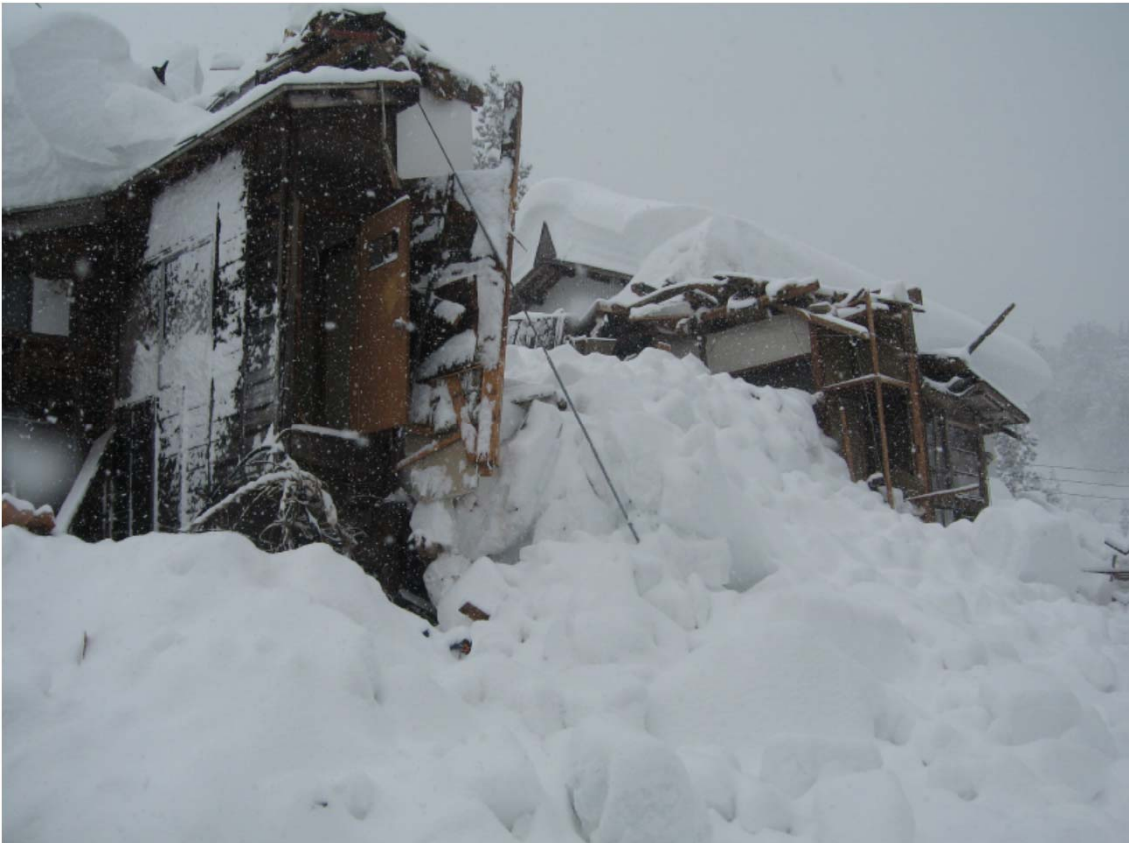
家屋の倒壊(新潟県十日町市) 写真提供:十日町市(H24.1.30撮影)
