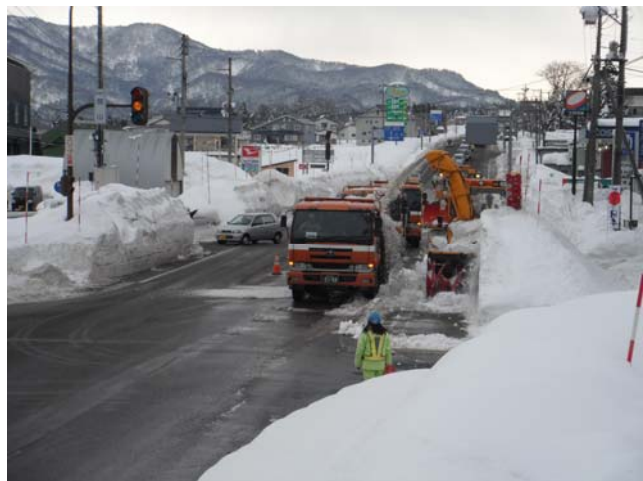
運搬排雪【国道18号 新潟県妙高市】 (H24.1.26撮影)
