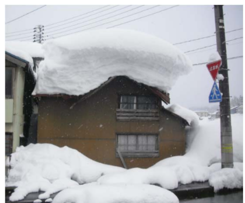
歩道へ落雪 新潟県魚沼市 写真提供:魚沼市(H24.2.3撮影)
