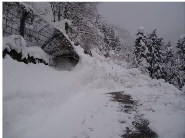
写真2 H18年豪雪による被災状況
