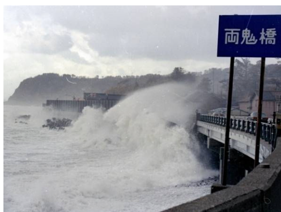
写真3 厳しい塩害環境下にある橋梁 (国道8号両鬼橋 新潟県糸魚川市)
