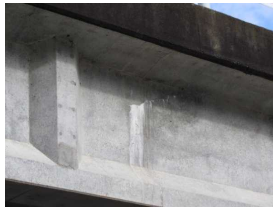
PC鋼材に沿ったひびわれと遊離石灰
