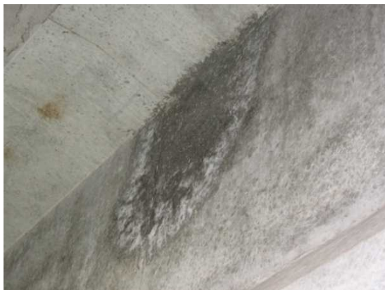
水しみ・遊離石灰
