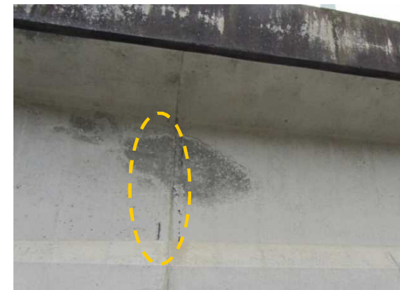
スターラップの腐食とコンクリートの剥離
