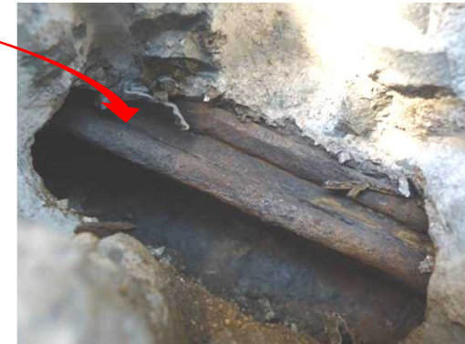
PCグラウトの充填不足によるPC鋼材の腐食
