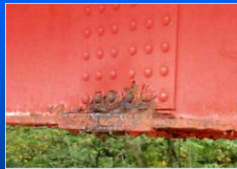
そのまま再締め付けはできない高力ボルト接合
