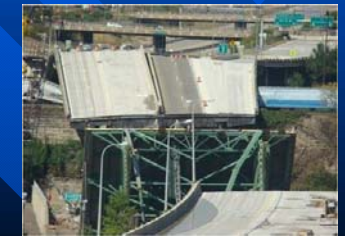
1格点の破壊による落橋
