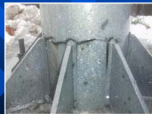
再溶接が困難な場合も多い溶接継手
