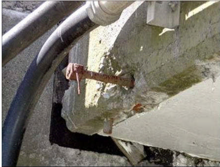
不完全な横締めグラウトによるPC鋼棒の突出
