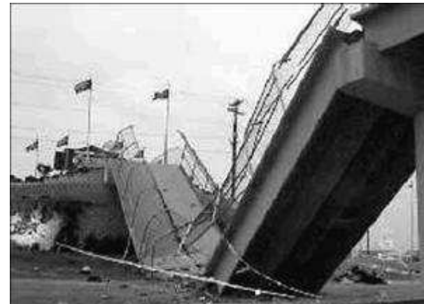
ノースカロライナ橋の落橋
