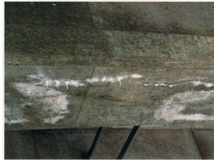
不完全な主げたのグラウトによるひび割れとエフロレッセンス
