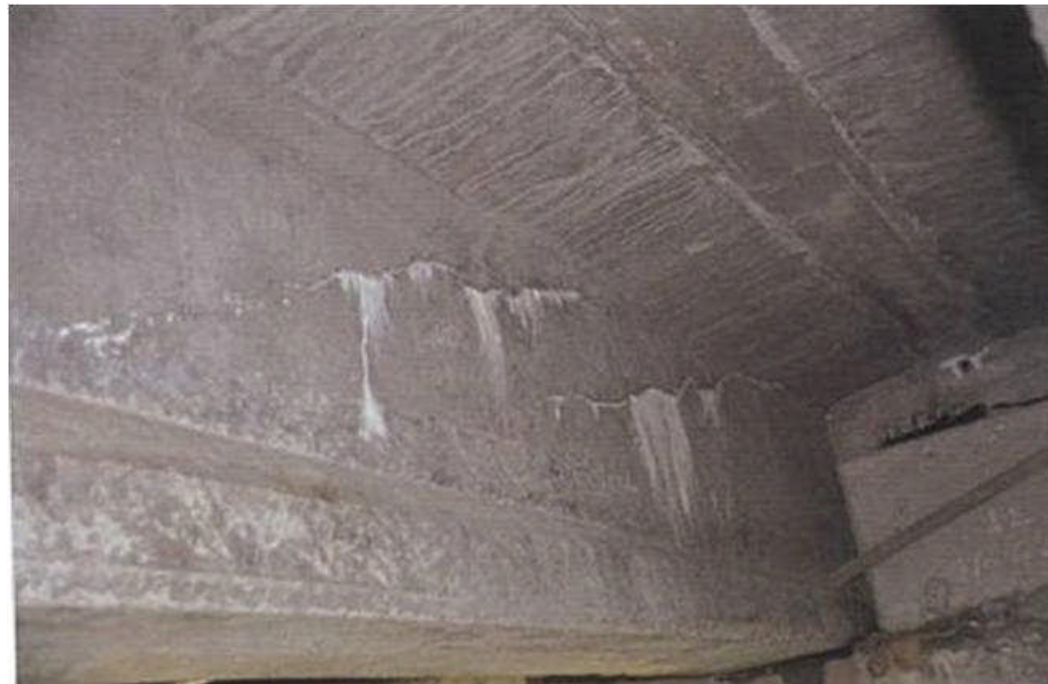
上縁定着の後埋め部から浸入した水による変状
