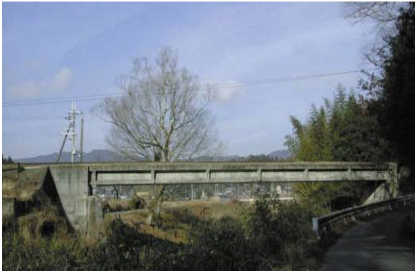
現在の第一大戸川橋梁 建設後60年経っても現役
