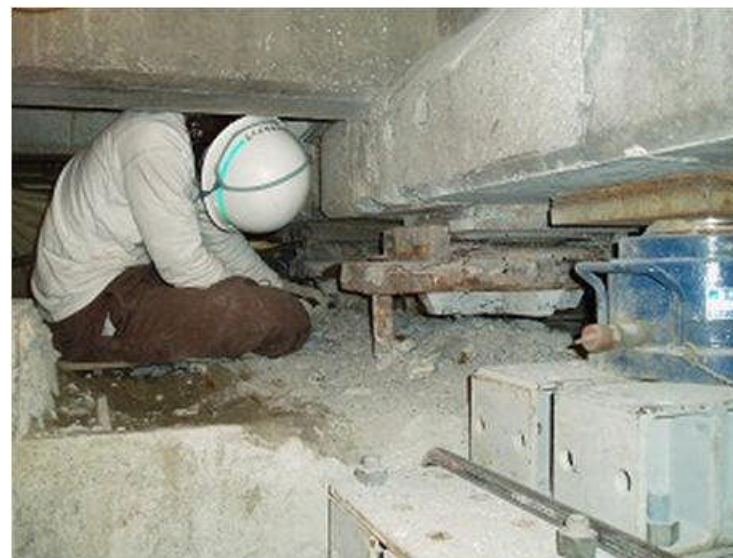
狭隘空間での既設支承撤去作業
