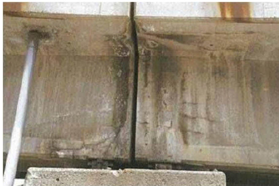
塩化物イオンを含む桁端部の漏水による劣化，PC鋼材の腐食
