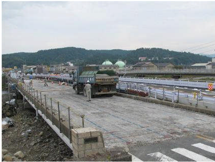
撤去橋梁を用いた振動計測
