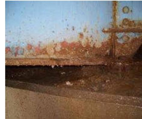
主桁端部の腐食
