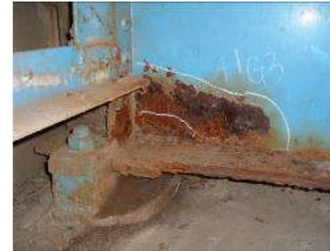
主桁端部の腐食、断面欠損
