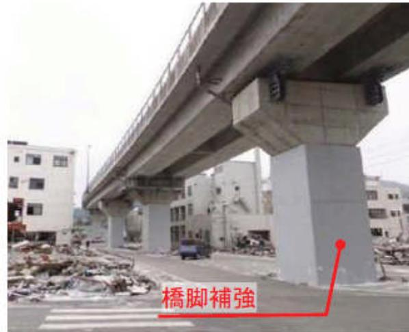
【耐震補強済み(鋼板巻立補強)】
