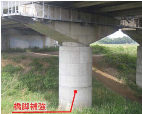
【耐震補強済み(RC巻立補強)】
