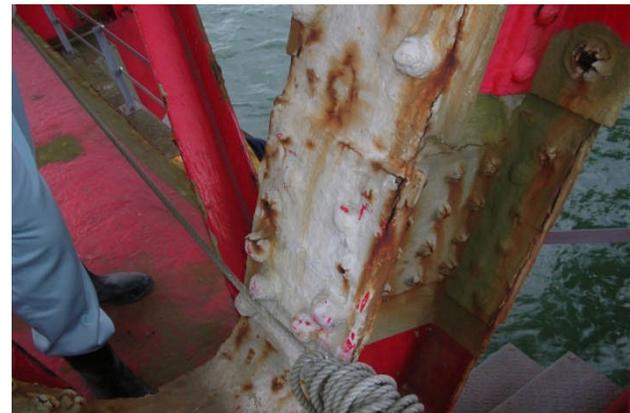
トラス部材の腐食状況
