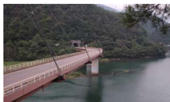
【国道156号 合掌大橋】
