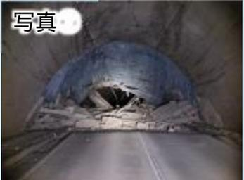
国道249号中屋トンネル崩落状況
