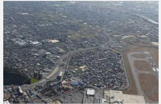
空港と市街地を結ぶ高規格道路（松山外環状道路）
