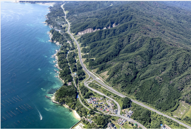
三陸沿岸道路（岩手県山田町）
