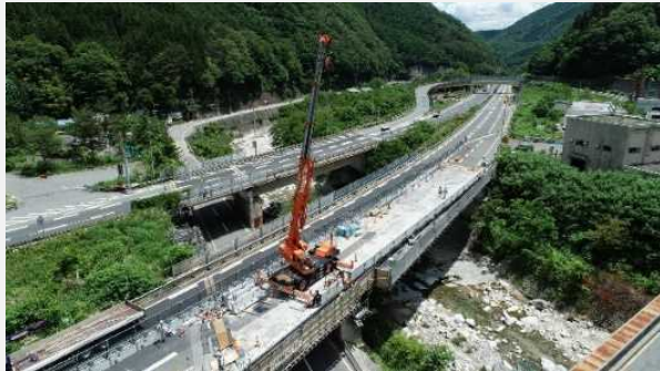
高速道路リニューアル（中央道 園原橋）
