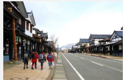
無電柱化・まちづくりとの融合（新潟県南魚沼市）
