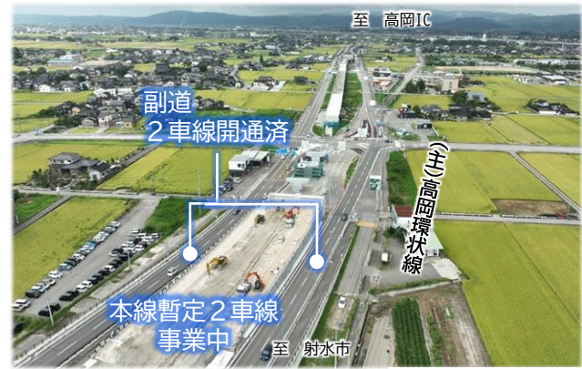
■ 写真4 (主)高岡環状線(上伏間江～佐野) (富山県施工)
