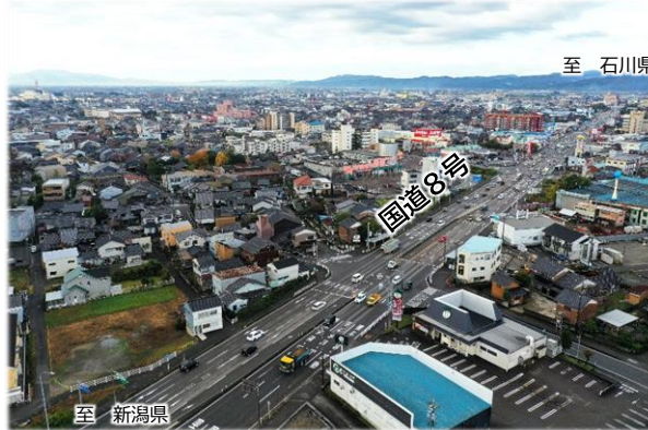
■ 写真1 国道8号 (向野本町交差点付近)
