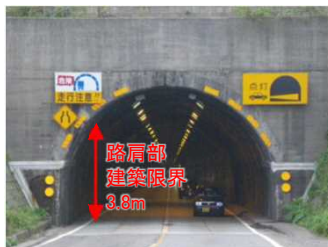
国道8号 新潟県柏崎市 米山トンネル (トンネル上空障害)
