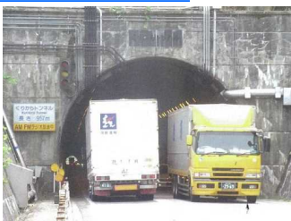
国道8号 富山・石川県境 倶利伽羅トンネル (狭幅員トンネル)
