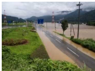
国道49号 新潟県阿賀野市 (H23.7 新潟福島豪雨による冠水)
