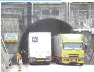
国道8号 富山・石川県境 俱利伽羅トンネル (狭幅員トンネル)
