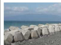
＜消波・根固ブロック＞
