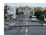
＜電柱倒壊による道路閉塞＞
