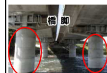
＜橋梁の耐震対策＞
