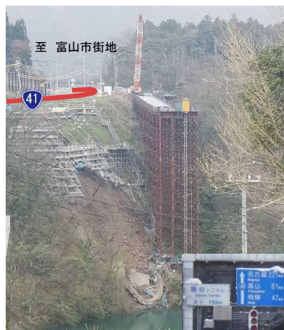
←国道41号現道脇 斜面崩落箇所
