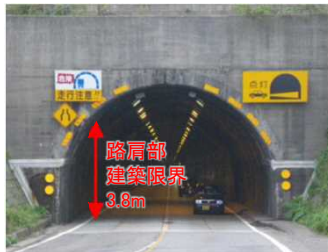
国道8号 新潟県柏崎市 米山トンネル (トンネル上空障害)
