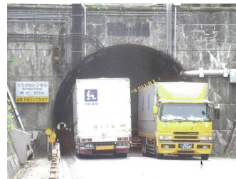
国道8号 富山・石川県境 倶利伽羅トンネル (狭幅員トンネル)
