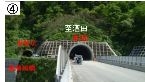
④ 日沿道温海トンネル(南側坑口) 至酒田
