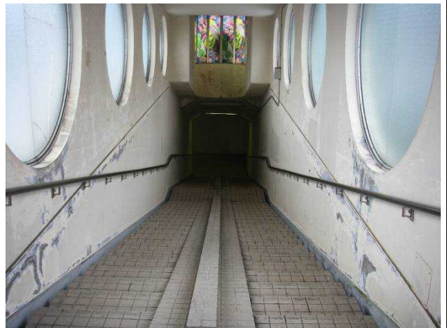
下り線側 ボックス内部
