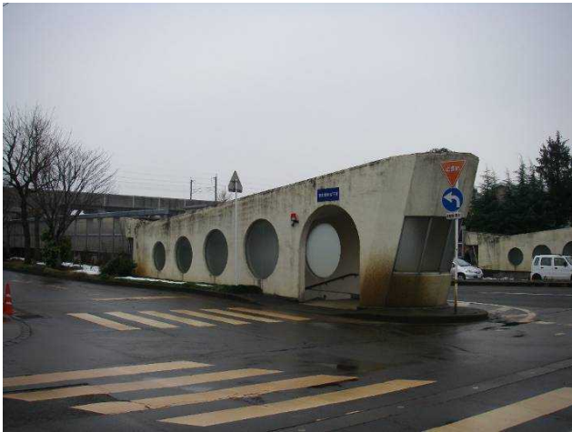
上り線側 ボックス外部
