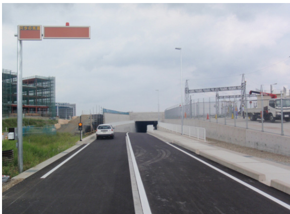
東側から西方(海側)を望む
