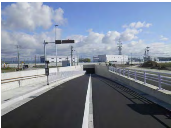
北側から南方(海側)を望む
