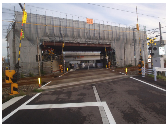
北側から南方(山側)を望む
