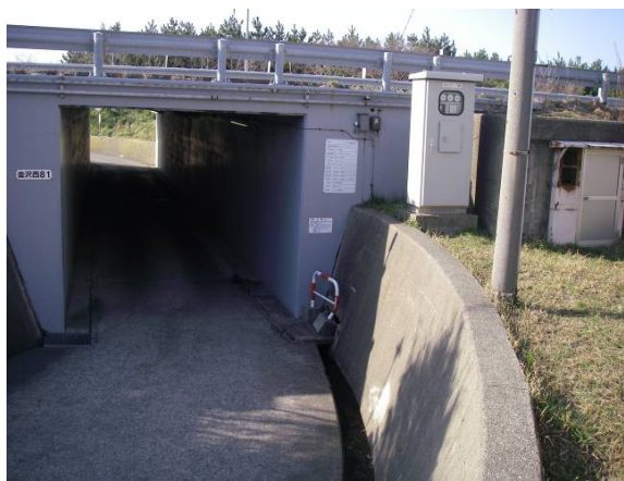
海側を望む (写真右 排水設備)
