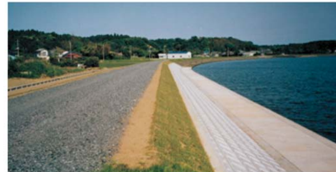
湖岸堤(霞ヶ浦開発、水資源機構)
