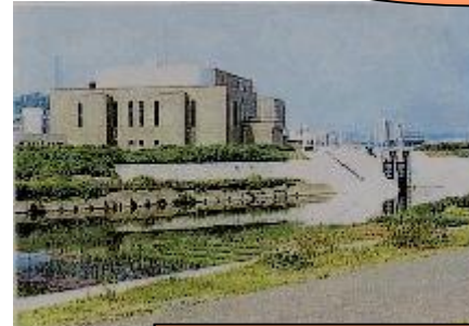
内水排除施設
