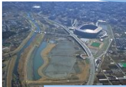
洪水調節施設
