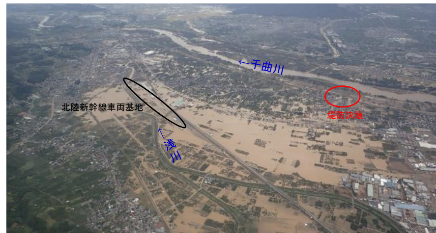
浸水状況(ヘリ調査10月14日11時撮影)
