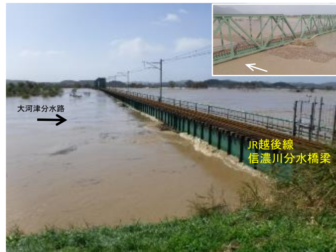
№18付近 JR越後線信濃川分水桥梁付近の状況 (10月13日11時55分時点)
