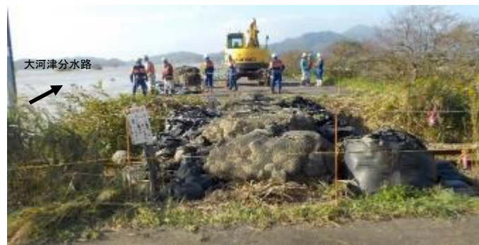
(右岸)土のう積 作業完了(燕市)
