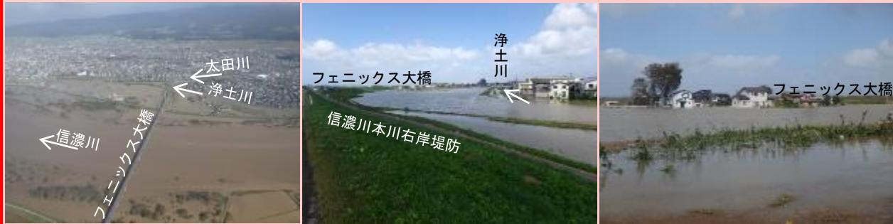
新潟県長岡市 今井 地先:越水【浄土川:太田川(県管理区間)合流点付近】
