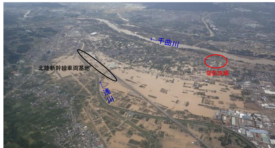
浸水状況(ヘリ調査10月14日11時撮影)
