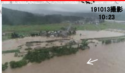
新潟県小千谷市 川井 地先:溢水【信濃川 右岸45.00km付近】
