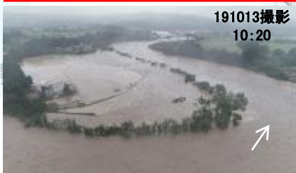
新潟県小千谷市 塩殿 地先:越水【信濃川 左岸44.00km付近】
