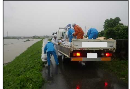
梯川左岸(佐々木町) 積み土のう工
