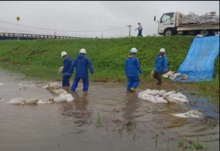
梯川左岸(荒木田町) 釜段工
