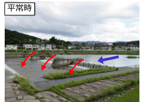
改築後 (可動堰)
