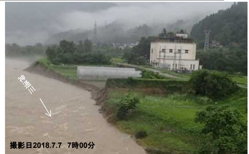
神通川左岸22.5K付近(富山市)
