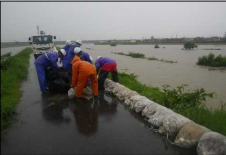
梯川左岸(佐々木町) 積み土のう工
