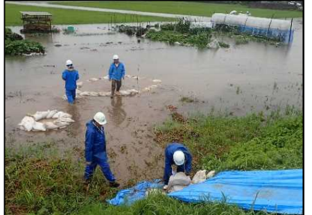
梯川左岸(荒木田町) 釜段工
