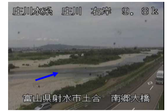
平時の南郷大橋の状況
