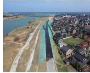
庄川は、砺波・射水平野を貫流する急流河川であり、ひとたび氾濫すると広範囲に甚大な被害が発生します。下流部は流下能力が大きく不足しており、下流部右岸堤防は、洪水を安全に流すことのできない弱小堤となっています。このため、治水安全度の向上を目的に、堤防整備等を実施します。
