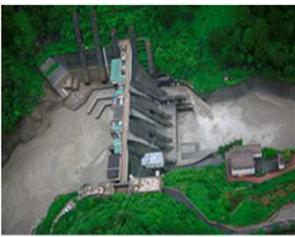
宇奈月ダムは洪水調節、水道用水の供給及び発電を目的として、平成13年度より管理を開始し、出し平ダム(関西電力)との連携排砂を実施しています。
