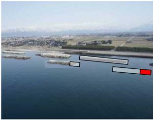
下新川海岸は、平成20年2月24日の高波被害において、直立堤や離岸堤等の海岸保全施設が被災し、越波により背後地の家屋に浸水被害が発生しました。
