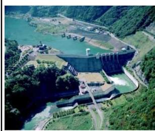
大川ダムは洪水調節、かんがい、水道用水、工業用水の供給及び、発電を目的として昭和63年に建設されました。平成26年から28年の3ヶ年で低水放流設備の計画的な補修を行い、機能維持を図ります。
