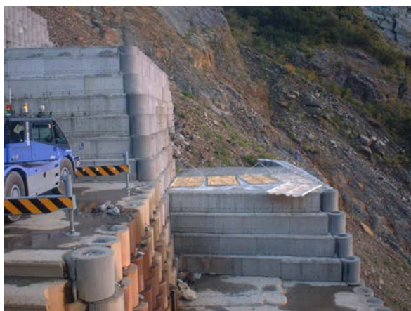
写真 3.21 養生シート（ユニット化）敷設
