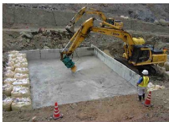
写真 3.23 打設面処理（レイタンス除去）
