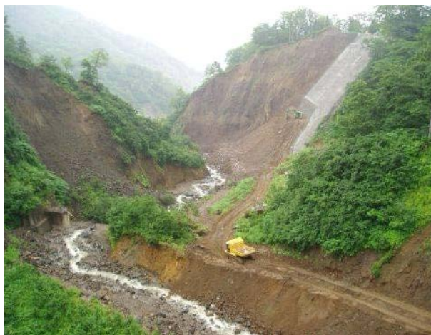
写真 3.26 積込場所へ向かう不整地運搬車
