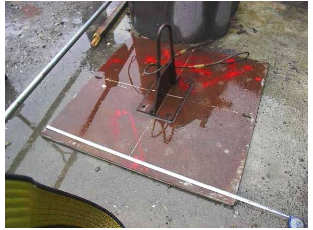
写真1.13 打設面仕上げ板
