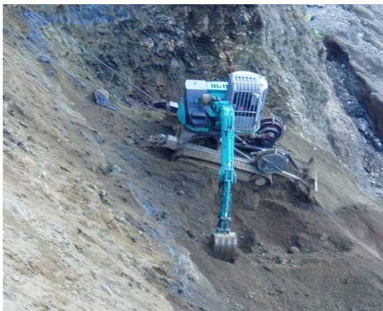
写真1.1 ワイヤーロープ吊下げ式掘削機(0.2m 3 級)
