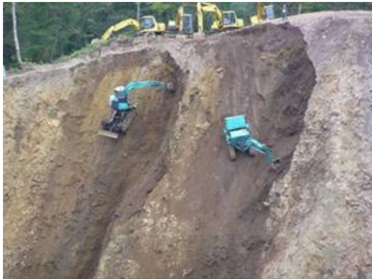
写真2.1 斜面对策工事例
