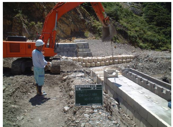
写真 3.10 型枠ブロック設置状況
