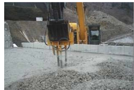
写真1.9 遠隔操作バイブレータユニット (電動式 \phi 60\text{mm} \times 3 本)
