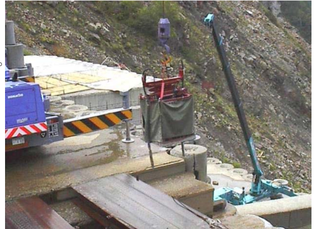
写真1.11 無線ミニクローラクレーン 吊下用バイブレータ
