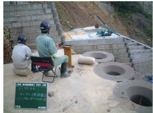
写真 3.18 ミクロクレーンによる締固め
