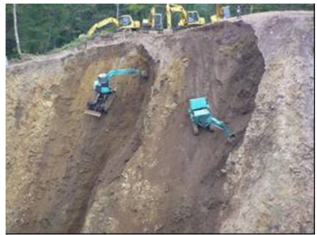
写真 3.25 ワイヤーロープ吊下げ式掘削機による法面整形状況
