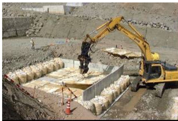
写真 3.20 養生シート（ユニット化）敷設
