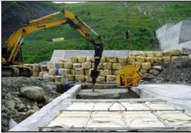
写真 3.11 クレーン投入及びバックホウ締め
