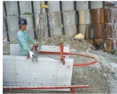
写真1.6 U型側溝設置補助機
