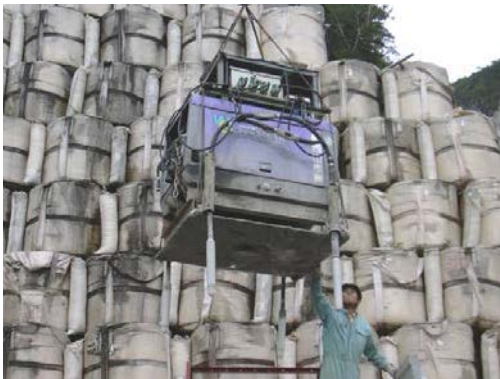
写真 3.17 無人ラフテレーンクレーンによる締固め
