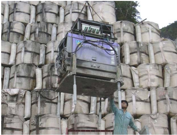
写真1.12 無人ラフテレーンクレーン 吊下用バイブレータ
