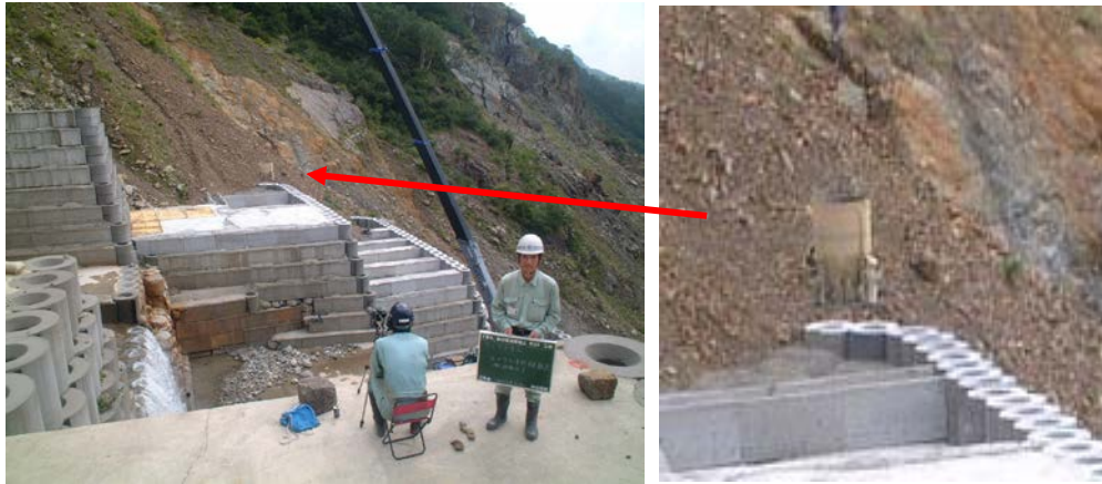
写真 3.16 無人ラフテレーンクレーンによる投入
