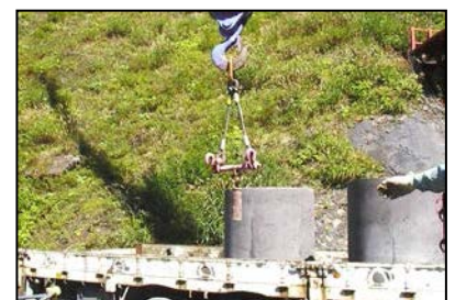
写真1.4 円形型枠吊り金具
