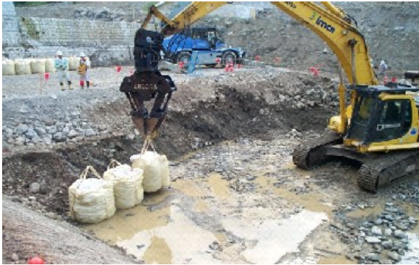
写真 3.5 大型土のう設置
