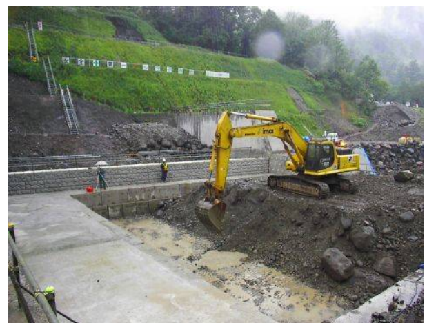
写真 3.4 目視による遠隔操作
