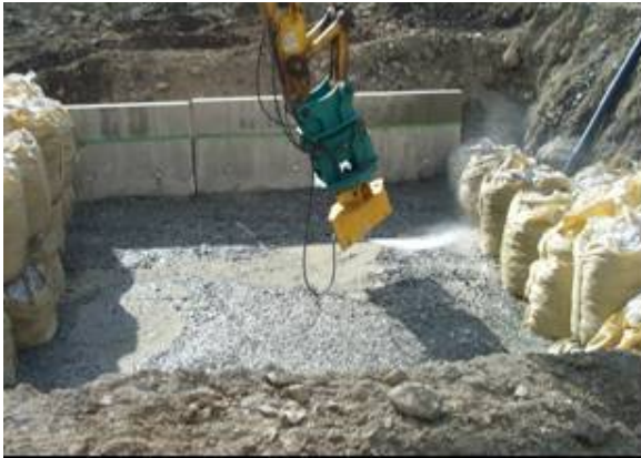
写真1.14 遠隔操作高圧散水ユニット
