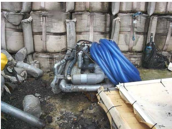
写真1.16 打設面清掃用散水装置
