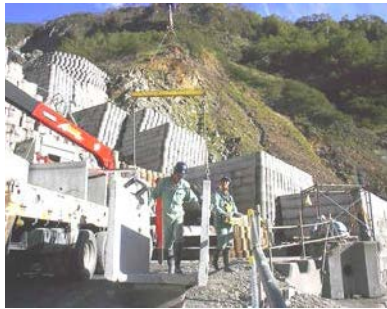
写真1.5 U型側溝吊り金具 (オートフック)
