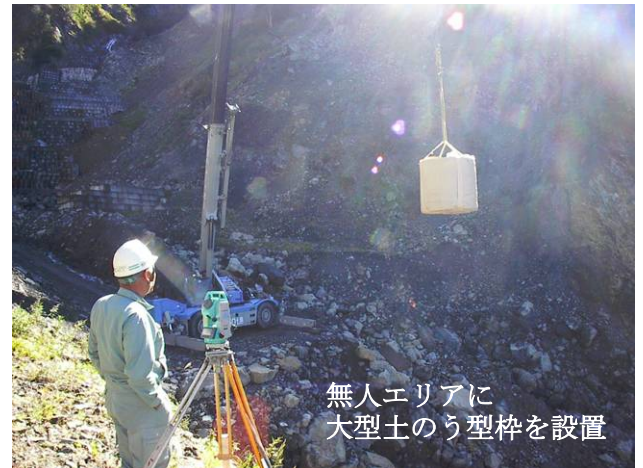
写真 3.2 ノンプリズムトータルステーションによる大型土のうの位置決め測量
