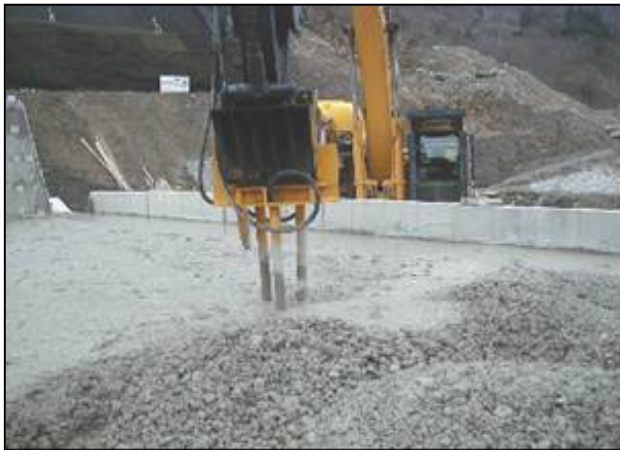
写真 3.13 バックホウ締め
