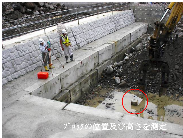
写真 3.1 ノンプリズムトータルステーションによる床掘り高さの測量
