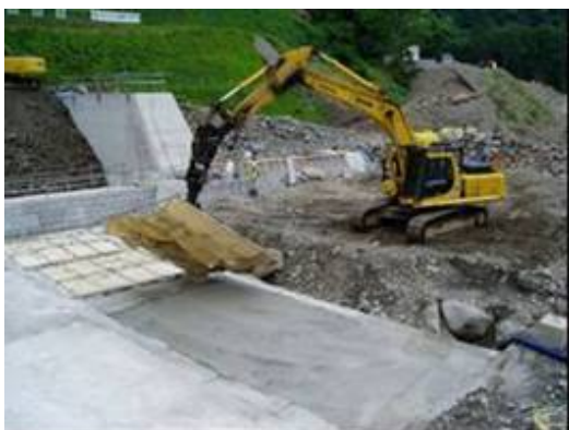
写真 3.19 養生シート（ユニット化）敷設
