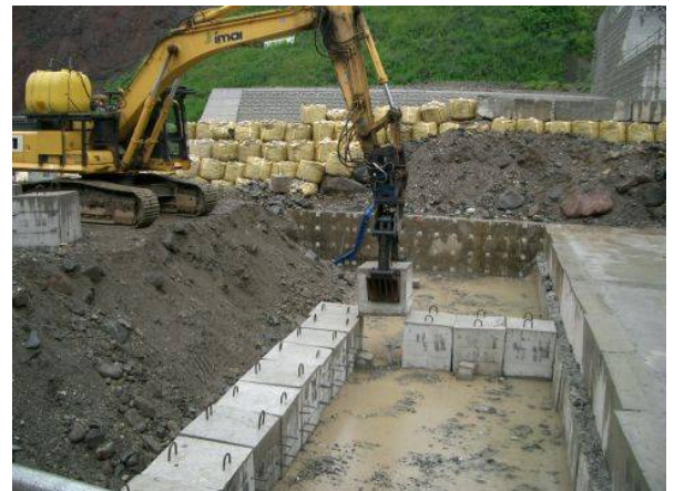
写真 3.8 コンクリートブロック型枠設置
