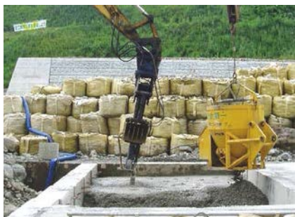
写真1.10 遠隔操作バイブレータユニット (油圧式 \phi 150\text{mm} )
