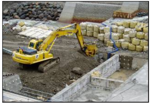
写真 3.12 バックホウによる投入
