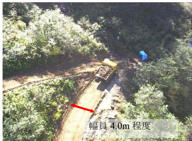
写真 3.27 運搬路の状況
