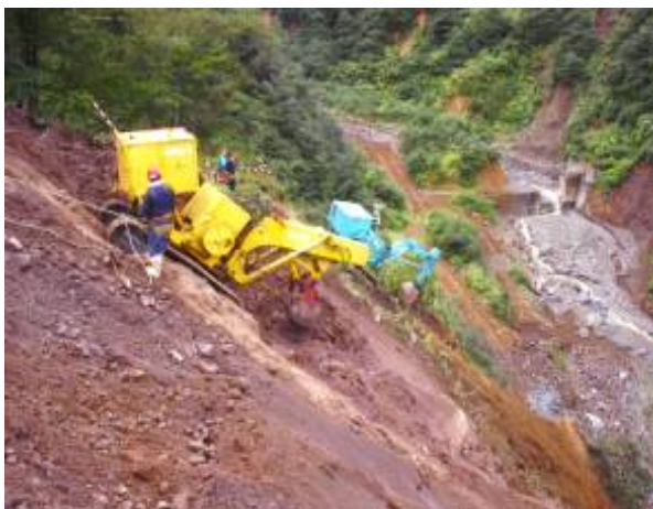
写真 3.24 ワイヤーロープ吊下げ式掘削機による斜面掘削
