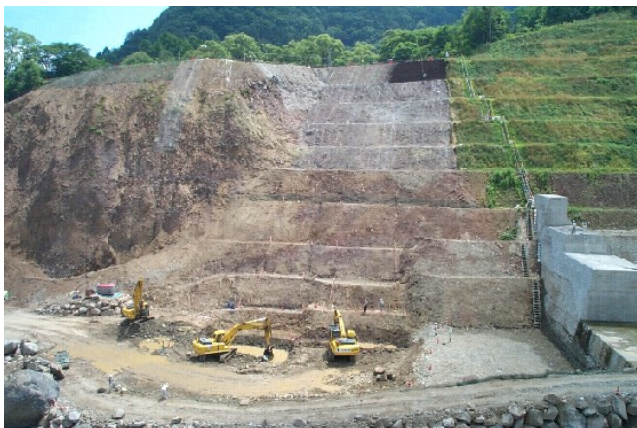
写真 3.3 無人化エリアと掘削状況
