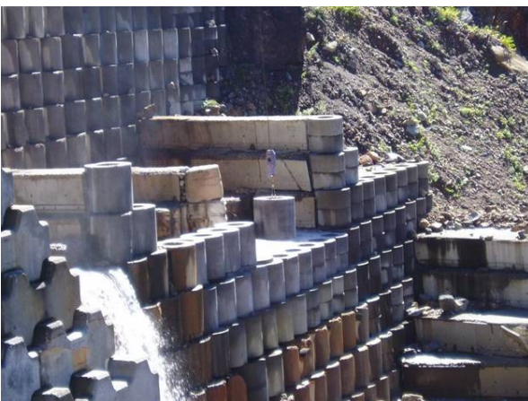
写真 3.9 円形型枠設置状況
