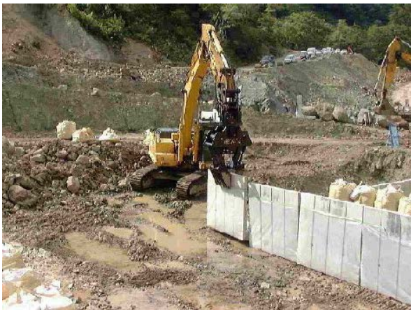
写真 3.7 L型擁壁型枠の設置
