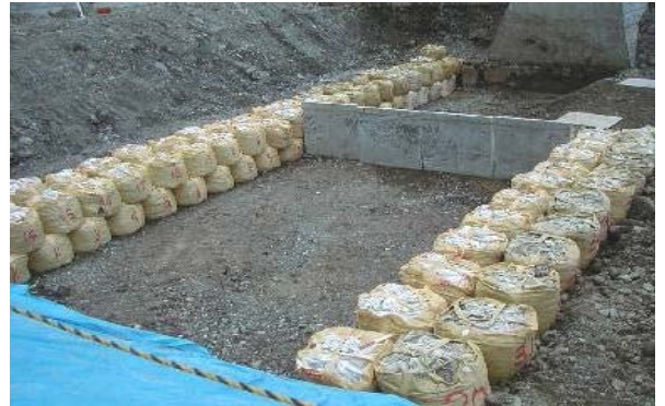
写真 3.6 型枠設置完了
