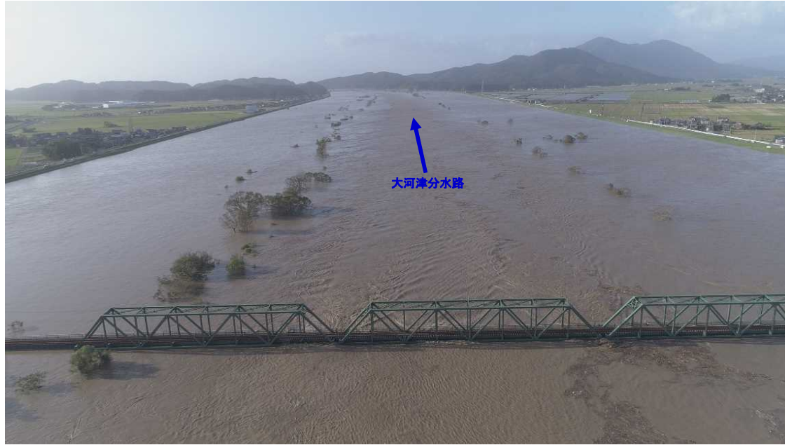
10/13 15:37 大河津分水路上空1k8 JR越後線 信濃川分水橋梁付近
