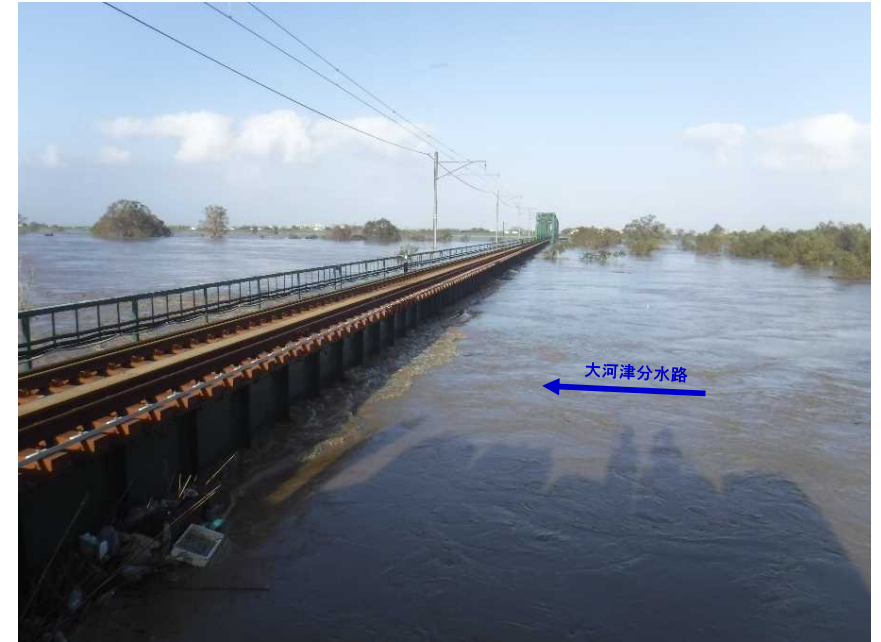
10/13 15:42 大河津分水路左岸1k8 JR越後線 信濃川分水橋梁付近
