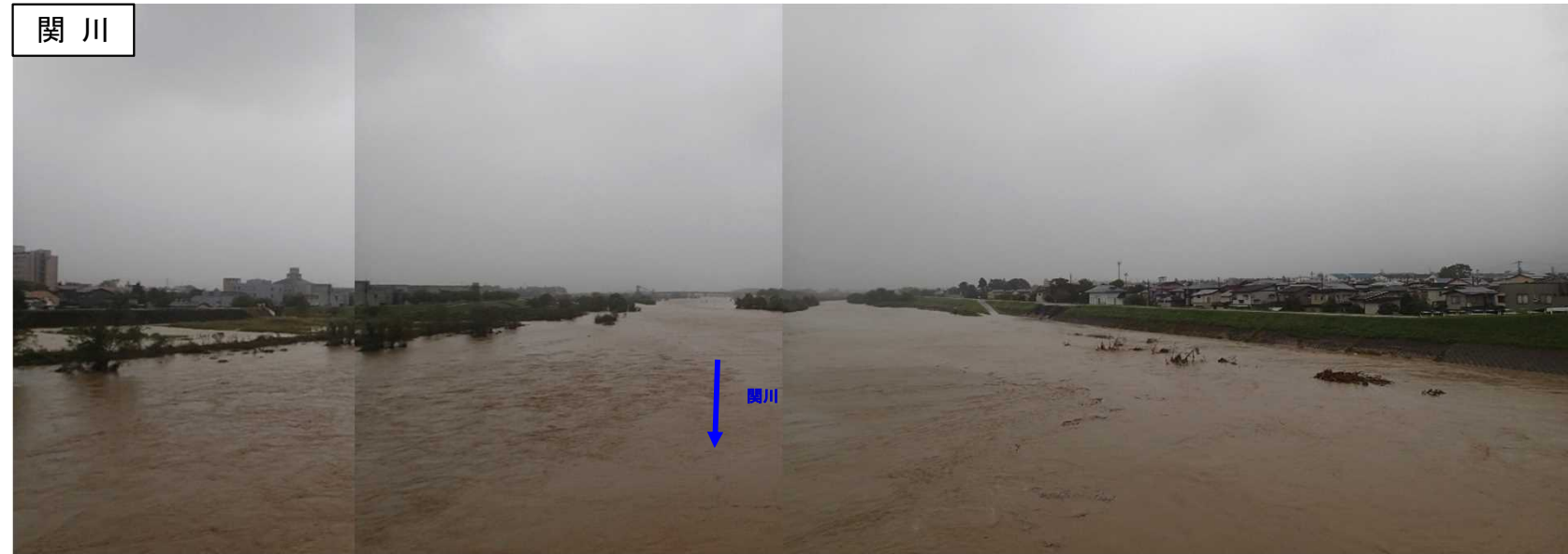
10/13 8:00 関川上空9.4k 中央橋付近
