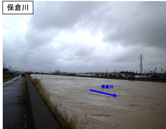
10/13 6:10 保倉川右岸0.5k 港町第四排水樋管付近
