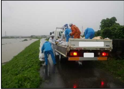
梯川左岸(佐々木町) 積み土のう工
