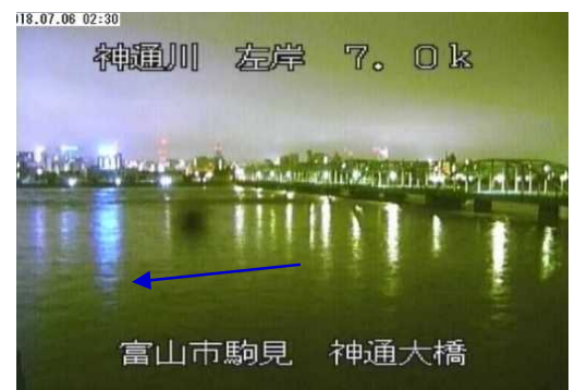
神通川大橋の状況(平成30年7月6日)
