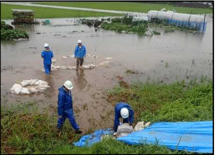
梯川左岸(荒木田町) 釜段工
