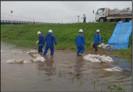
梯川左岸(荒木田町) 釜段工
