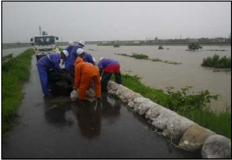
梯川左岸(佐々木町) 積み土のう工
