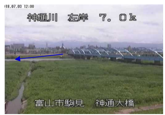
平時の神通川大橋の状況
