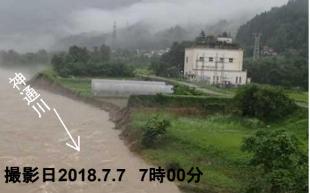
被災状況（増破後）
