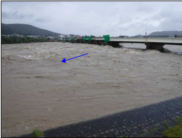
【信濃川水系信濃川】旭橋下流の状況 (新潟県小千谷市)
