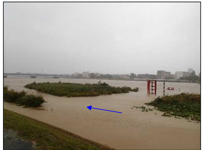
【関川水系関川】高田観測所の状況 (新潟県上越市)
