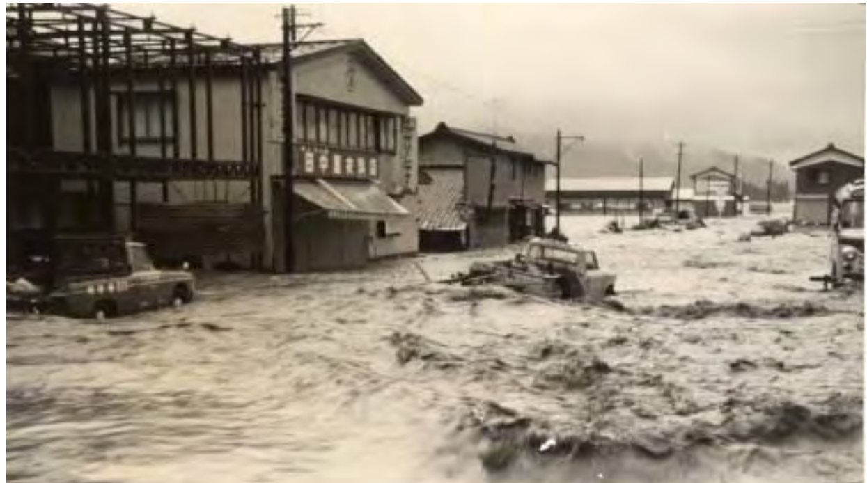
荒川(新潟県) S42洪水
