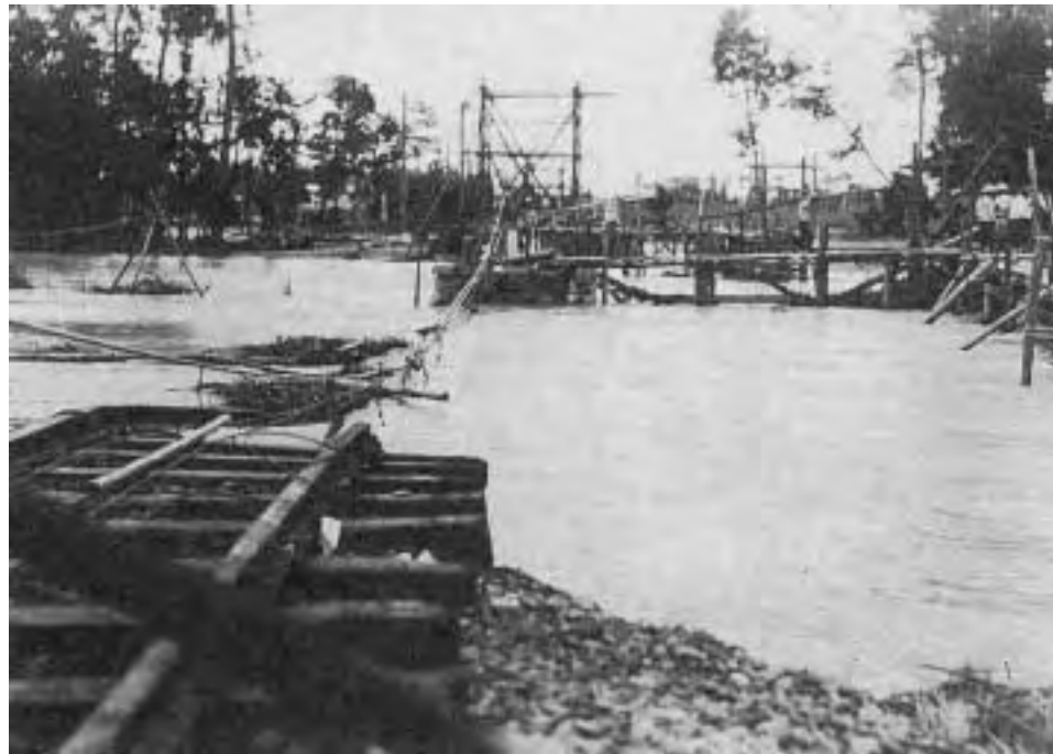
氾濫流によるJR北陸線の破壊
