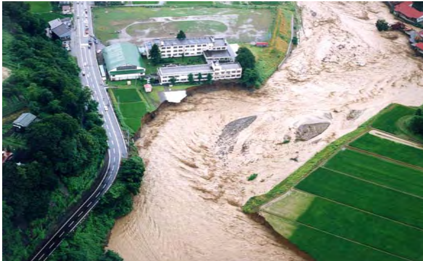
関川：平成7年7月洪水(新潟県新井市除戸地先)
