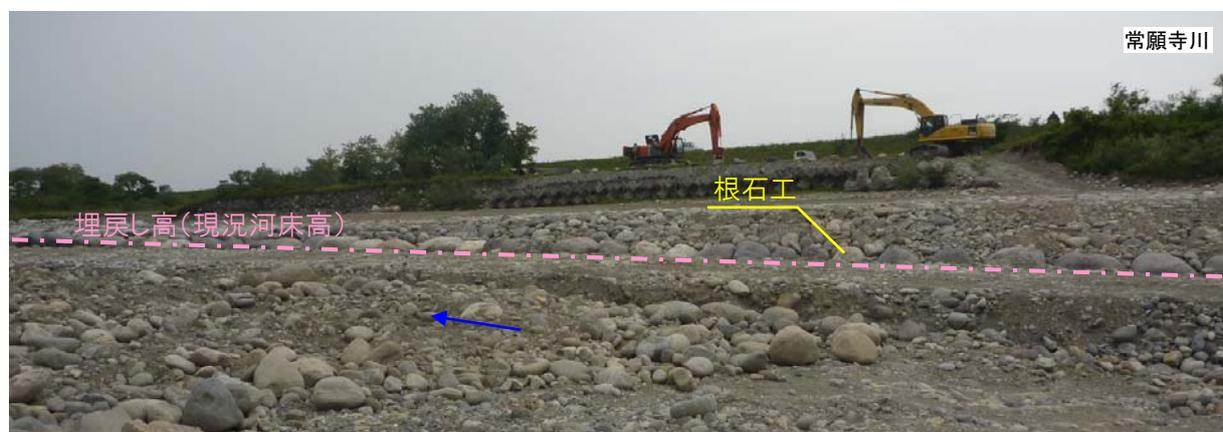
図 3.3.11 現況河床高に沿って施工された根石工（常願寺川）
