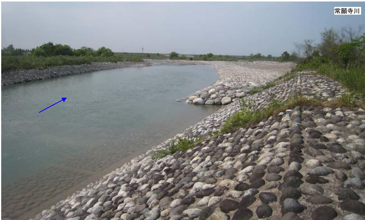
図 3.3.28 通水後の巨石付き盛土砂州を用いた河岸防護工設置状況
