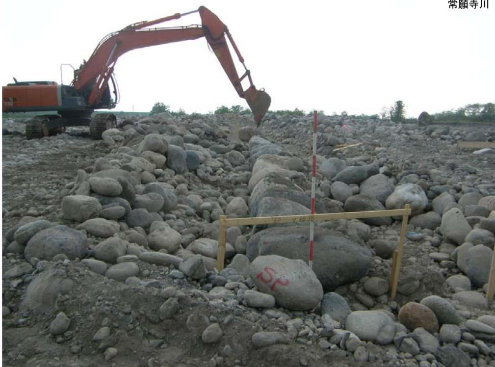
図 3.3.24 根石工施工状況
