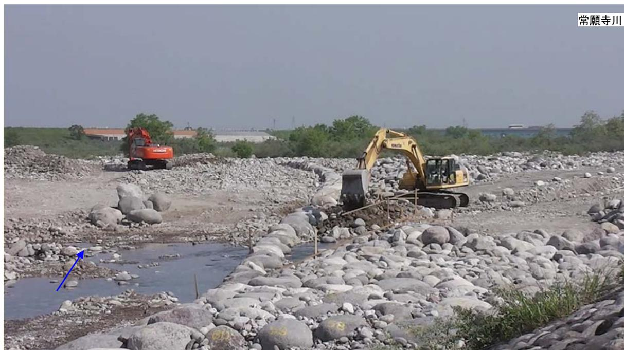
図 3.3.25 法面施工状況（中詰盛土工の法面形成時）
