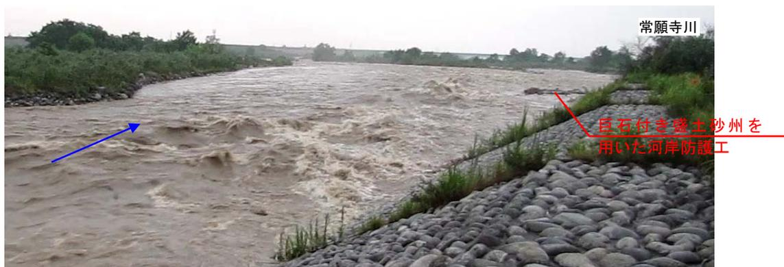
図 3.3.5 出水状況（巨石付き盛土砂州を用いた河岸防護工の天端高以上の水位）
