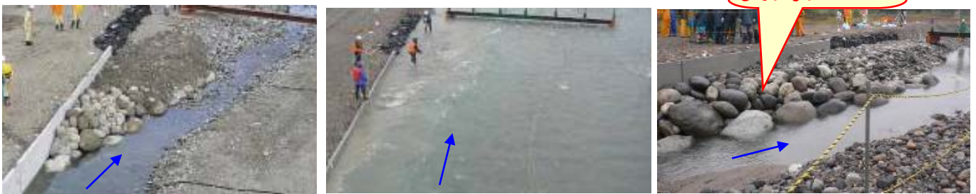
図 3.1.12 巨石付き盛土砂州を用いた河岸防護工の効果
