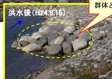
図 1.1.5 巨石付き盛土砂州を用いた河岸防護工 (H24.6 施工)
