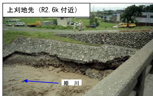
図 1.1.2 平成 7 年 7 月洪水の姫川の護岸工の被災状況
