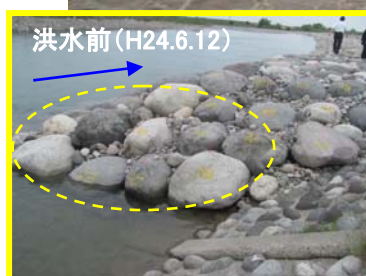
図 1.1.5 巨石付き盛土砂州を用いた河岸防護工 (H24.6 施工)
