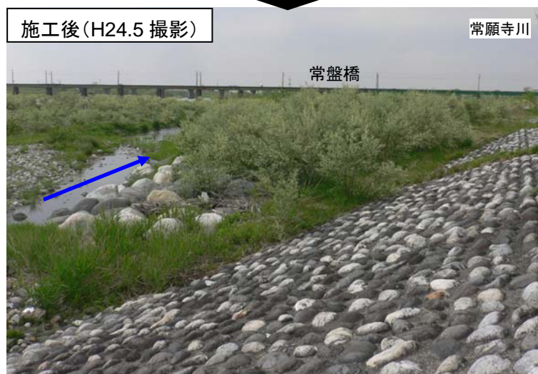
図 1.1.4 巨石付き盛土砂州を用いた河岸防護工 (H19.2 完成)
