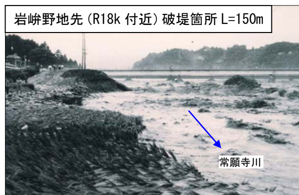
図 1.1.1 昭和 44 年 8 月洪水の常願寺川の破堤状況
